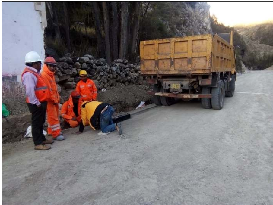
Fotografía 6. Vista de la instalación de la viga Benkelman al camión.
