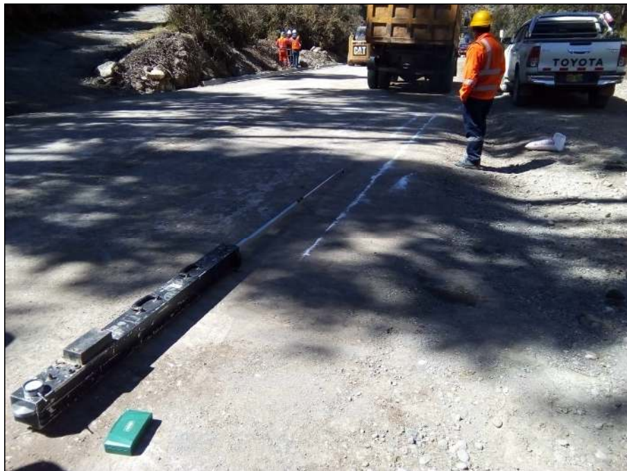
Fotografía 8. Medición de la deflexión del pavimento por medio de la viga Benkelman en el carril derecho de la vía.
