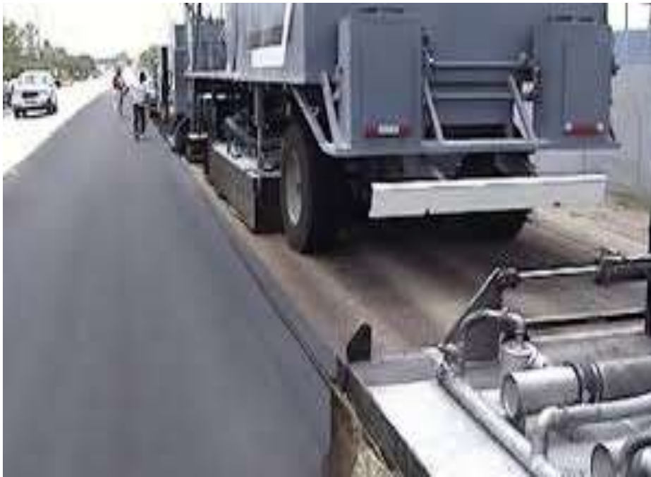
Figura N° 4-Extracción del pavimento asfáltico
