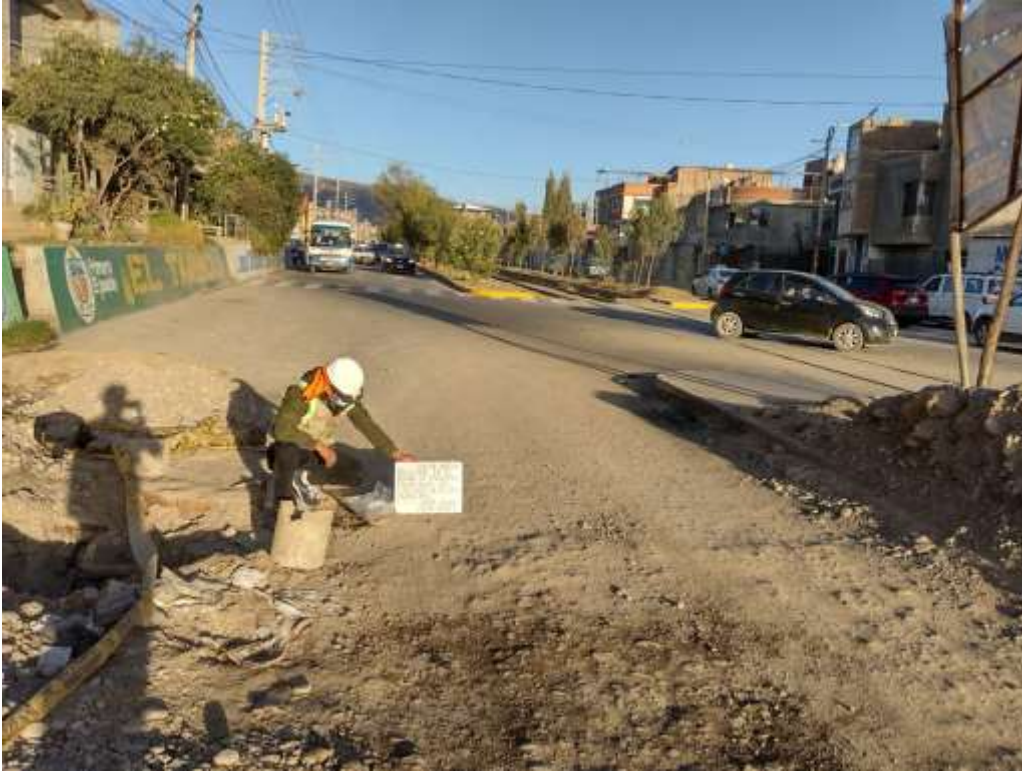
Figura N° 8-Toma de muestra de pavimento existente
