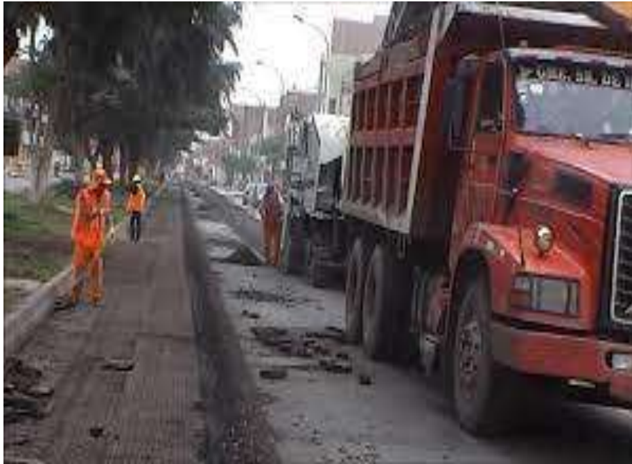
Figura N° 5-Fresado del pavimento flexible
