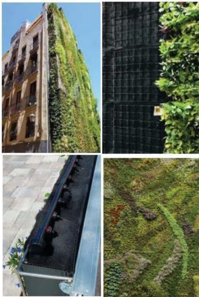
Figura 3 “(componentes de un jardín vertical) Fuente: Sánchez 2021”
