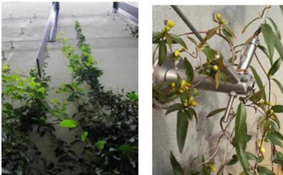
Figura 8 (componentes de un jardín vertical) Fuente: Sánchez 2021”
