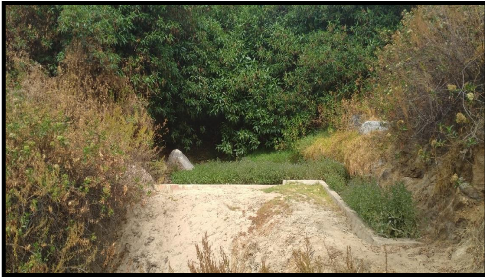
Fotografía 17: Inicio de canal San José.
