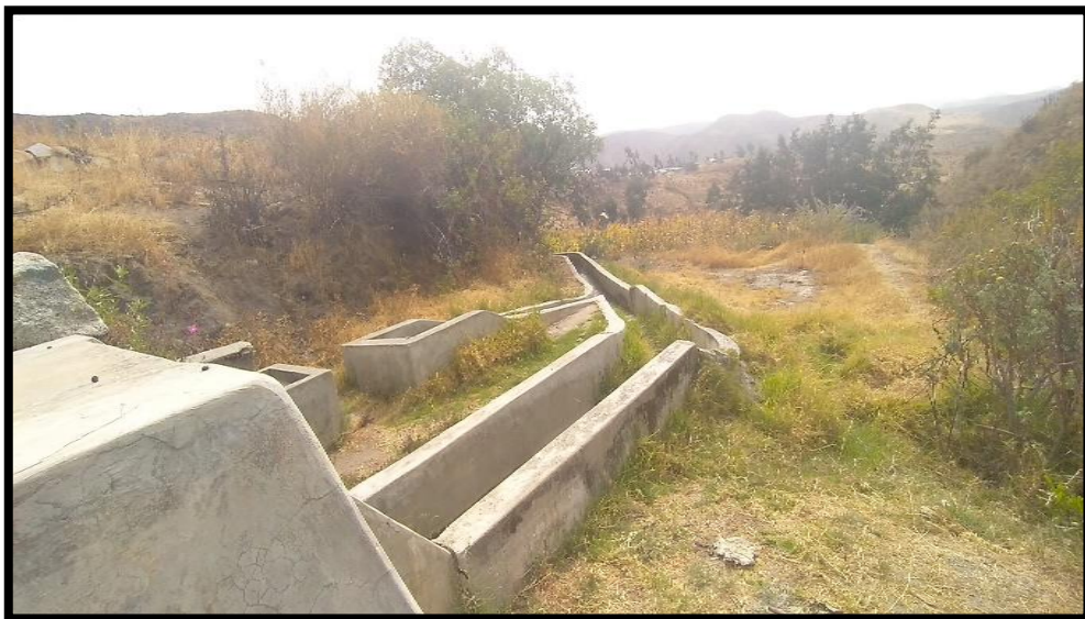
Fotografía 18: Estructuras existentes canal de riego.
