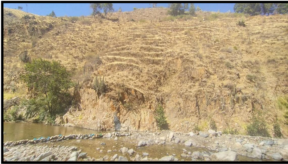
Fotografía 08: Inicio de canal Lucmayocc.
