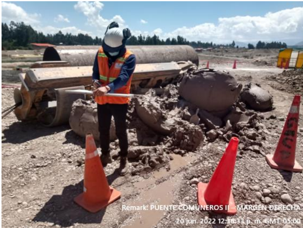
Fotografía 1. Acondicionamiento del área de trabajo – CCO Suelos
