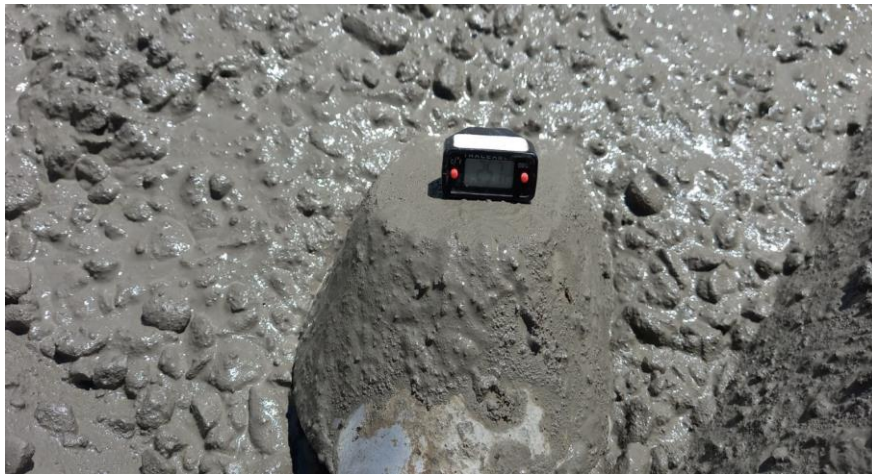
Anexo N°2 Control de temperatura de concreto en obra.
