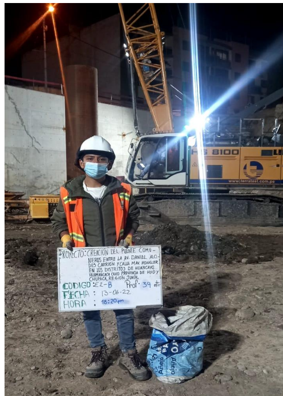
Anexo N°4 Toma de muestra de suelo en obra.
