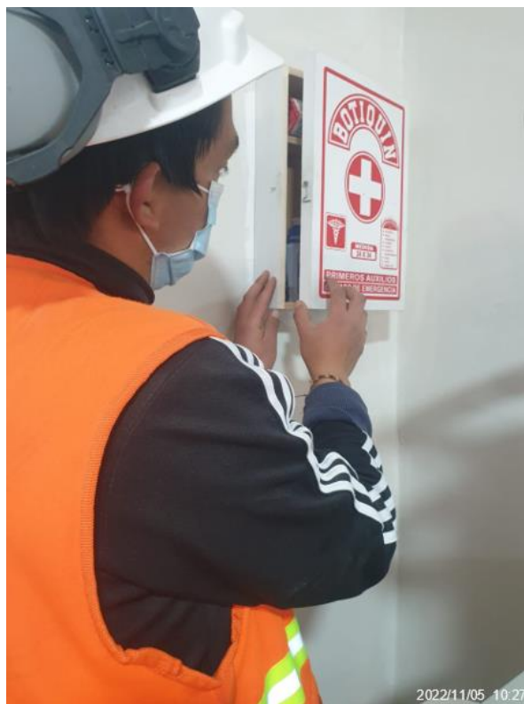
Fotografía 10. Inspección de botiquín de primeros auxilios
