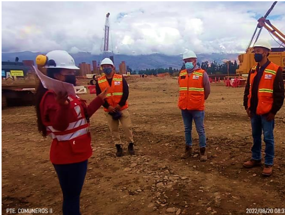
Fotografía 14. Charla a personal en obra y llenado de formato ATS Elaboración propia
