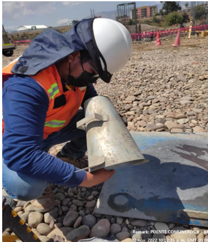
Fotografía 12. Inspección de herramientas - CCO Concreto
