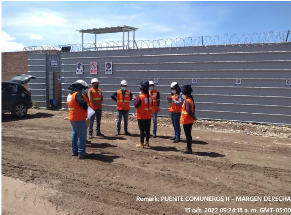
Fotografía 5. Capacitación de Inducción antes ingreso a obra
