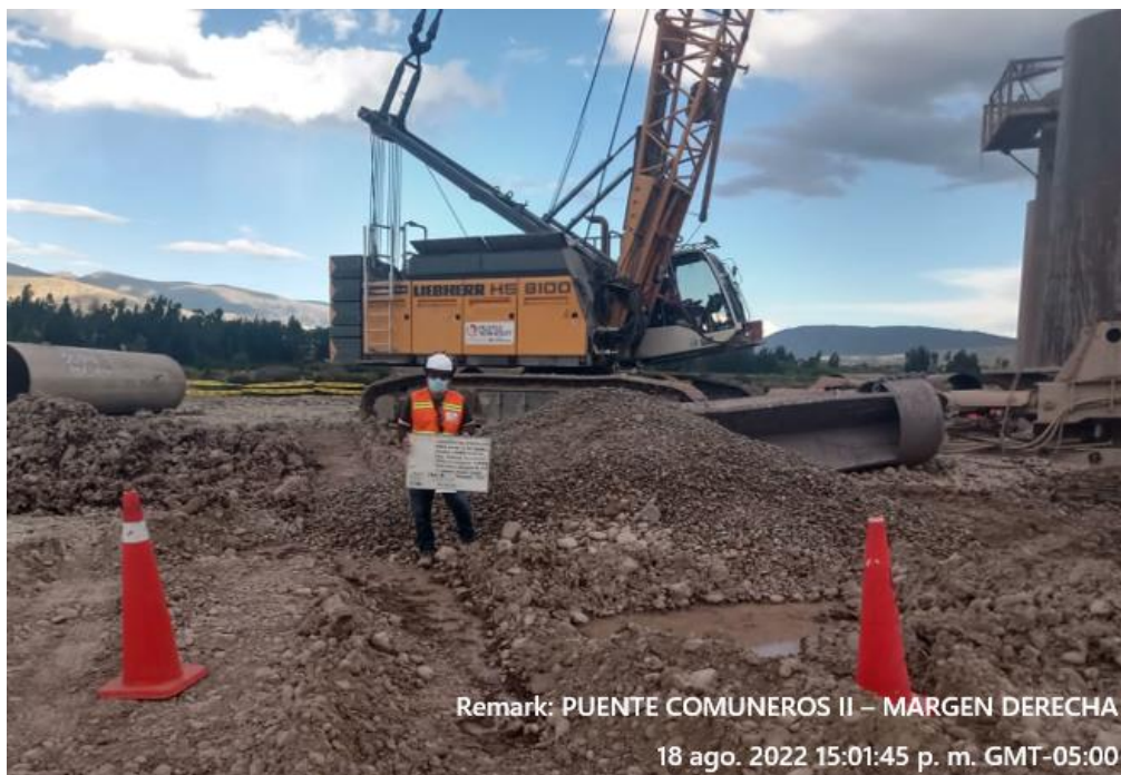
Fotografía 2. Área de trabajo despejada sin maquinaria en movimiento
