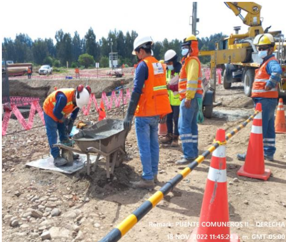
Fotografía 16. Implementación de barreras de seguridad para delimitar el área de trabajo Elaboración propia
