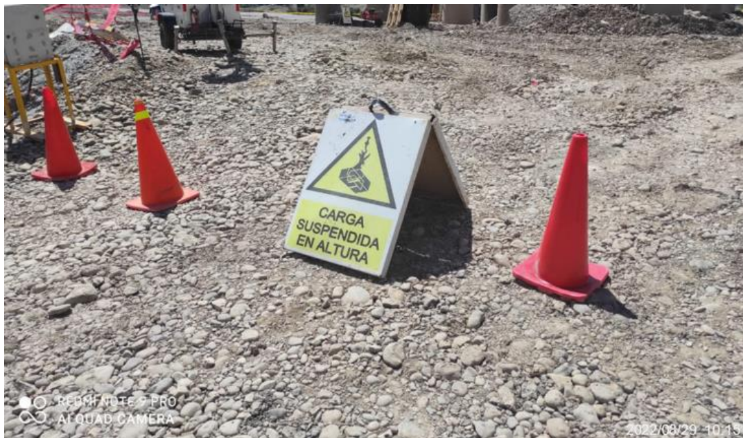
Fotografía 4. Colocación de señalética en las áreas de trabajo
