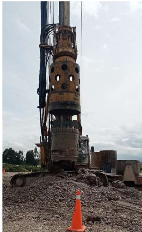
Figura 1.1 Perforación de Pilotes Pre-excavados
