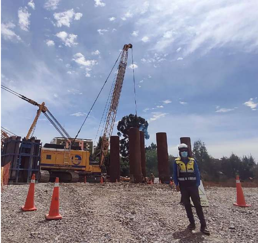
Control de la perforación de pilotes pre-excavados
