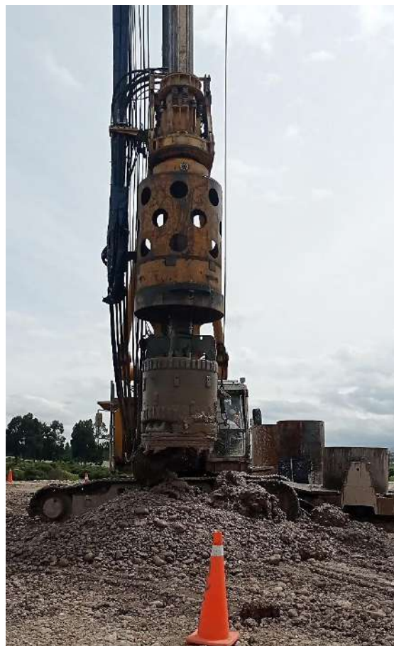
Figura 1.1 Perforacion de Pilotes Pre-excavados
