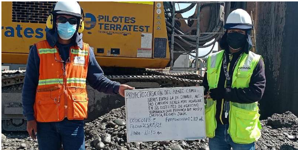
Se llevó el control de la perforación conjuntamente con la supervisión
