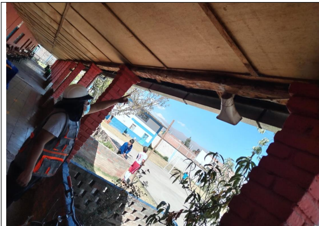
Mejoramiento del campo deportivo y del sistema de drenaje pluvial.
