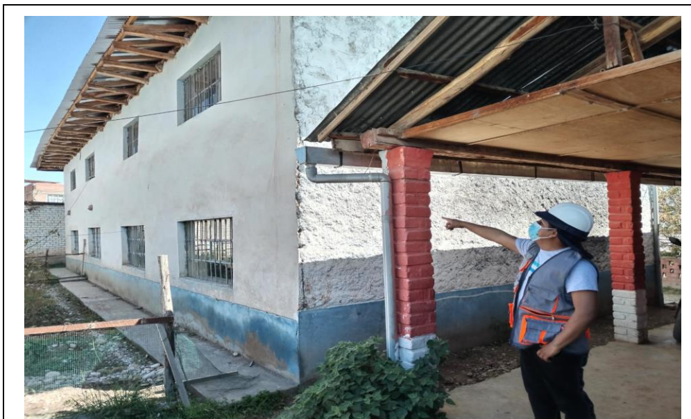
Mejoramiento del sistema de drenaje pluvial en techos.
