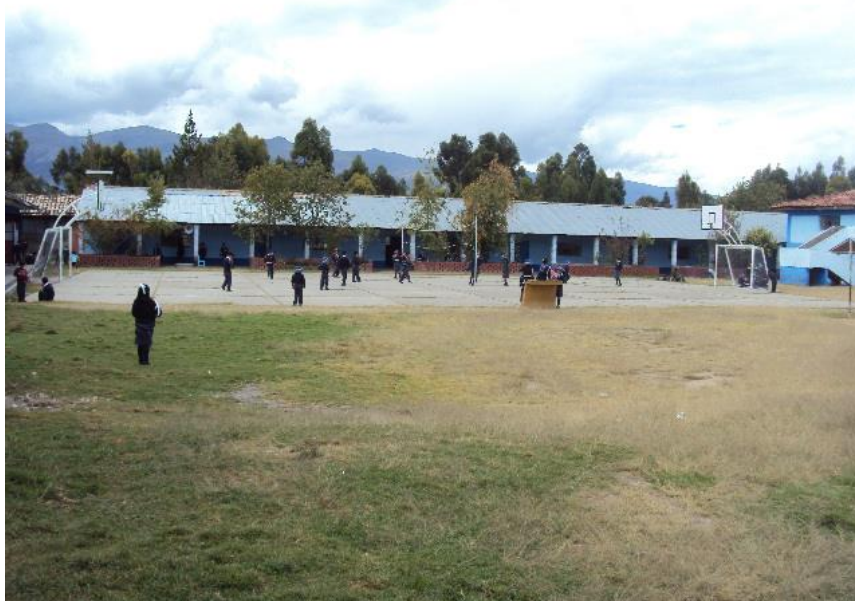
Vista panorámica de la Infraestructura destinada al Área Complementaria (Almacén, Cafetería, cocina y despensa)
