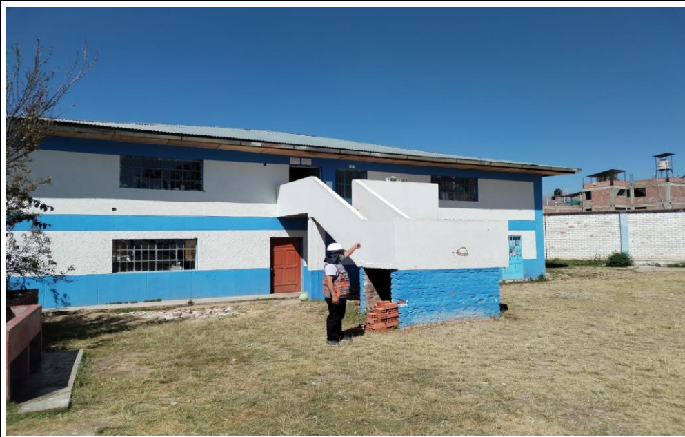
Mejoramiento actual de la Infraestructura destinada al Área Administrativa.
