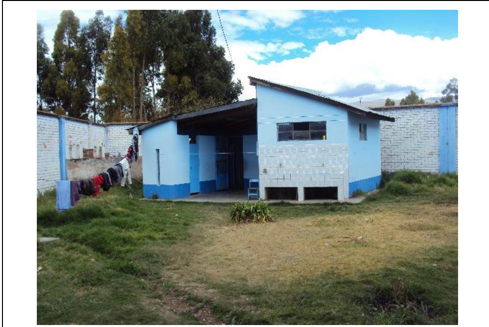
Servicios Higiénicos y tanque séptico.
