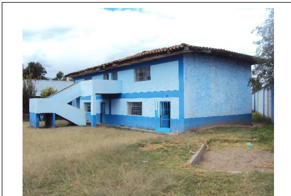
Vista de la Infraestructura destinada al Área Administrativa.
