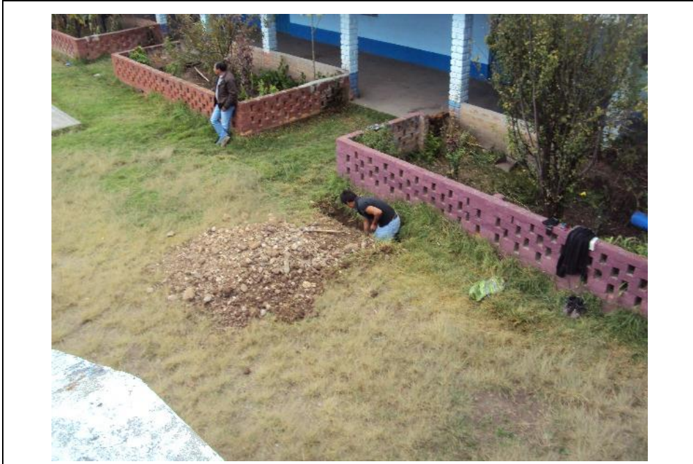
Excavación de calicatas
