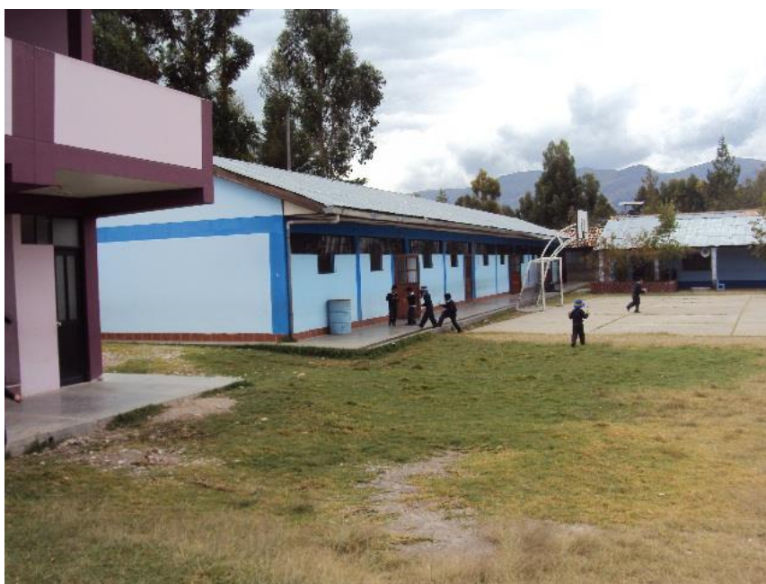
Vista de la infraestructura destinada al Área pedagógica (04 aulas insuficientes)
