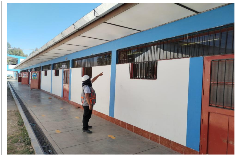
Mejoramiento de la infraestructura destinada al Área pedagógica.
