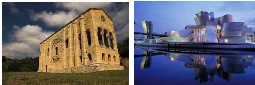
Figura 8: Materiales de construcción de un edificio antiguo y moderno.
