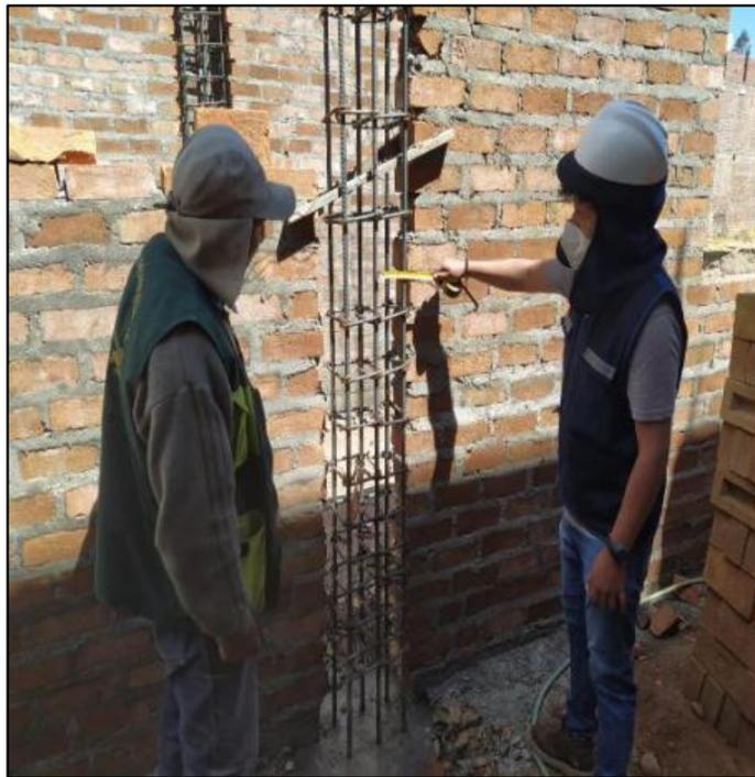
Fotografía 13: Verificando medida para el endentado y el amarre posterior de columna -viga.
