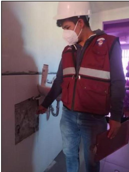
Fotografía 8: Se observa la humedad en muro y el desprendimiento del enchape debido a la filtración de agua en la tubería.
