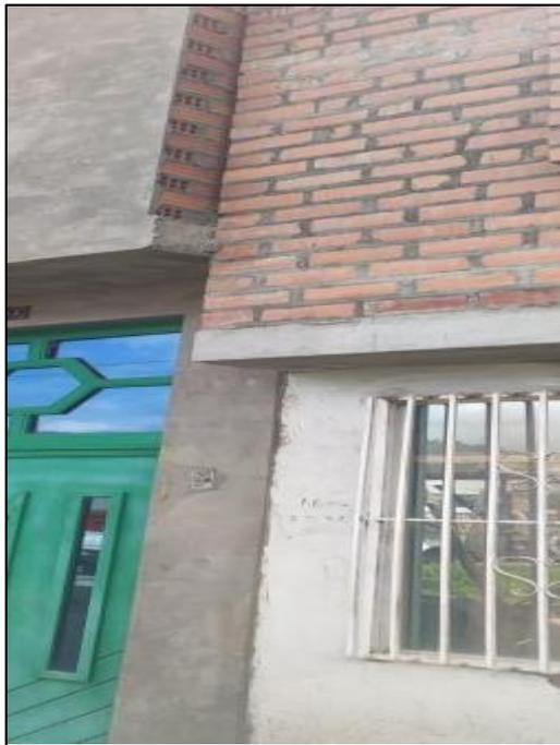
Fotografía 19: Se puede ver la falta de junta sísmica entre viviendas.
