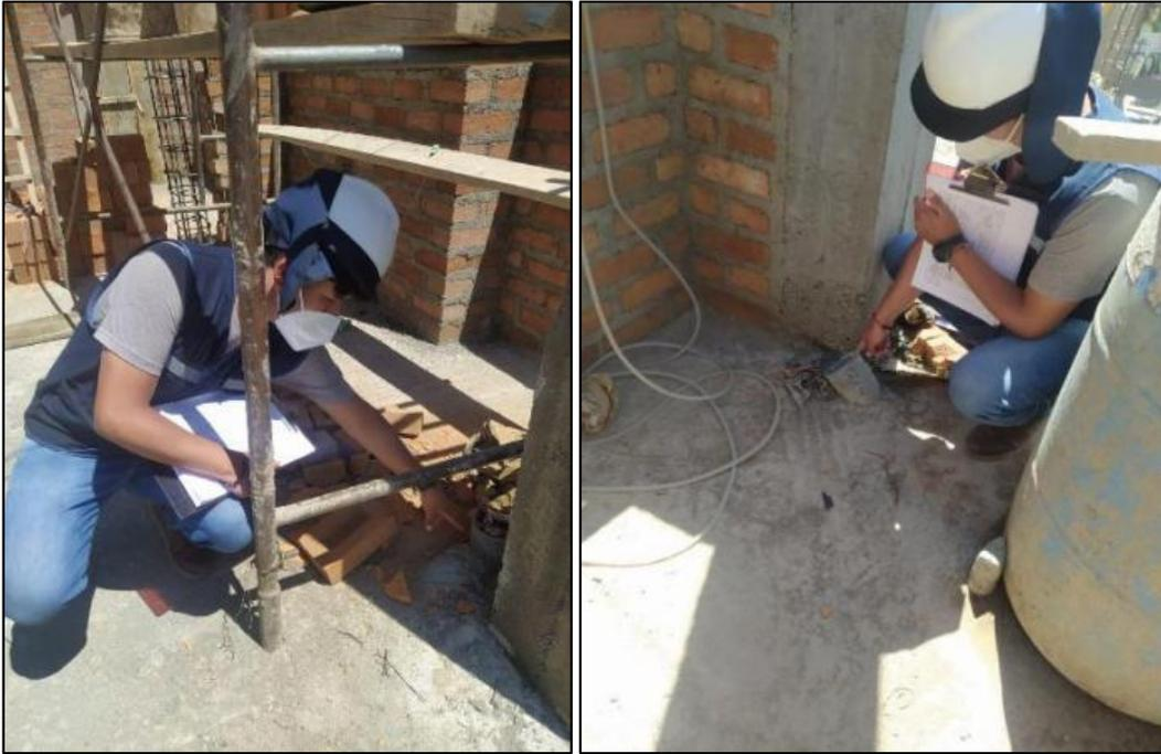
Fotografía 9 y 10: Se logra observar la instalación de tubería sin ningún fin por la falta de planos y supervisión.
