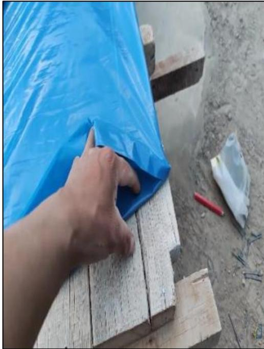
Fotografía 22: Se puede observar que la madera para el encofrado se encuentra cuartada y no es apta para ser utilizada.
