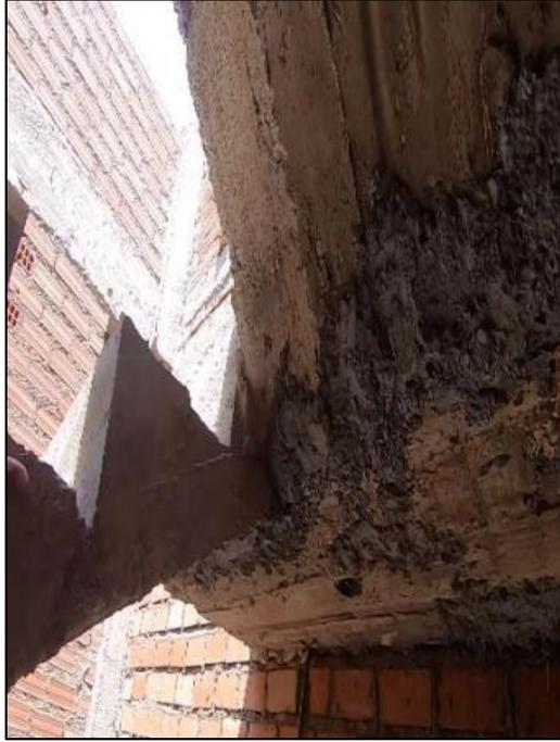
Fotografía 21: Se observa la estructura de escalera con cangrejas, el acero expuesto y la medida de la garganta demasiado delgada.
