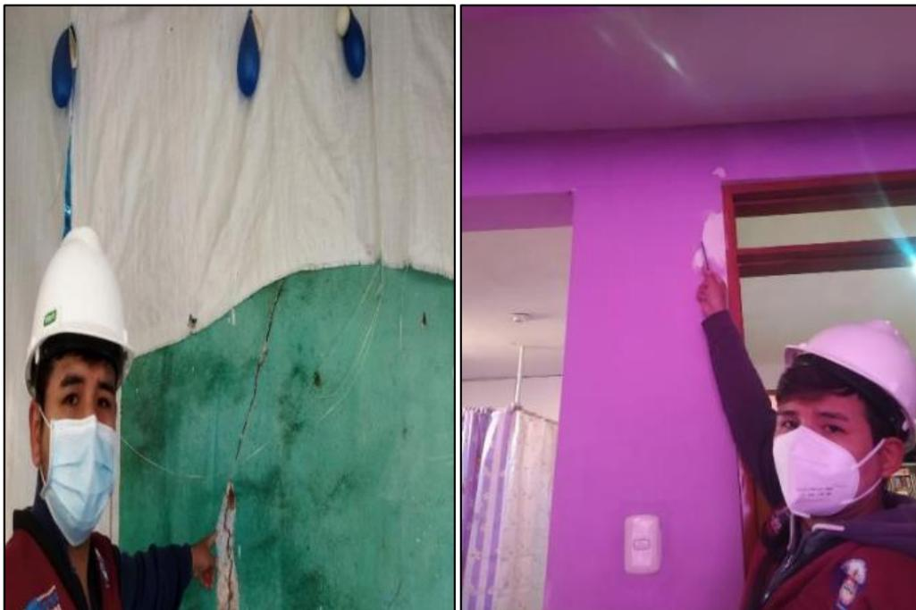
Fotografía 2 y 3: Se puede observar una fisura en muro.
