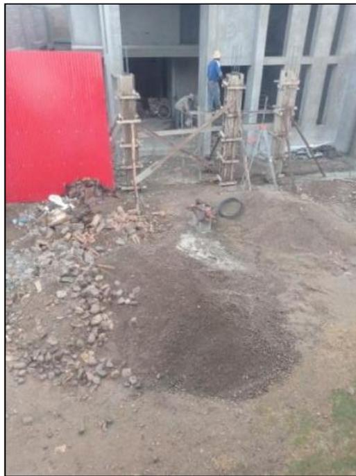
Fotografía 24: Se puede observar la falta de aislamiento del agregado con materias contaminantes.
