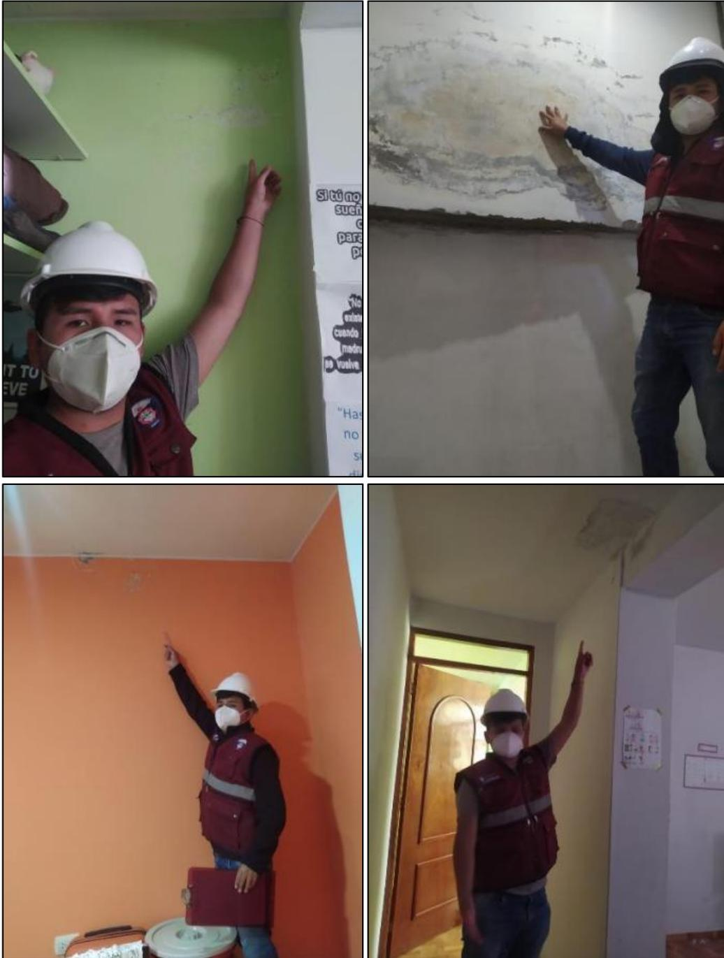
Fotografía 14, 15, 16 y 17: Se puede observar la humedad en los muros debido a la filtración de agua en tuberías.
