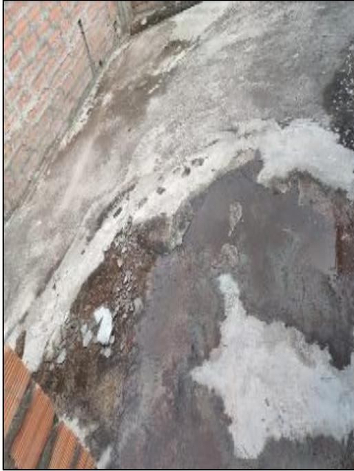
Fotografía 20: Se puede ver la falta de recubrimiento en techo, por ende, la acumulación de agua por las lluvias.
