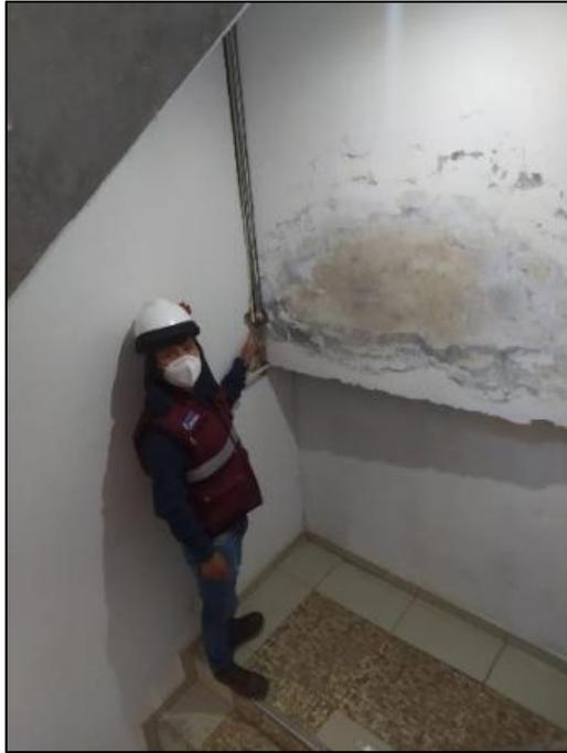
Fotografía 18: Se logra observar una tubería expuesta debido al nulo conocimiento de lectura de planos y poco criterio del maestro constructor.
