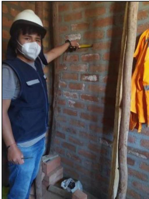
Fotografía 11: Se observa que las juntas de mortero no cumplen con la medida normada en la NTE.070.
