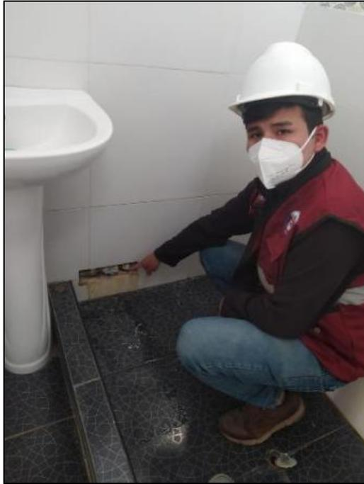
Fotografía 4: Se puede observar filtración de agua debido a la falta de mantenimiento en la llave de inspección de tubería de agua fría.
