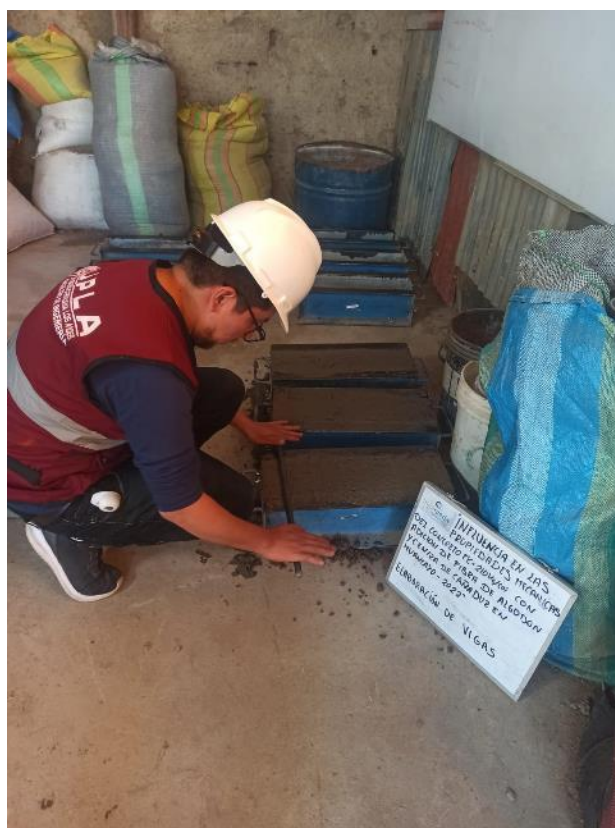
Ilustración 82. Elaboración de vigas para ensayos de flexión.
