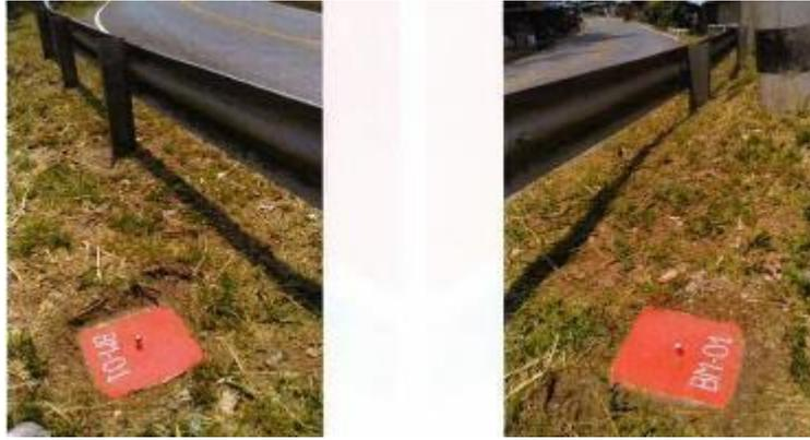
Figura N° 7: Vista del BM-01 ubicado en la Progresiva 0+046.00 del Proyecto del muro contención. Figura
