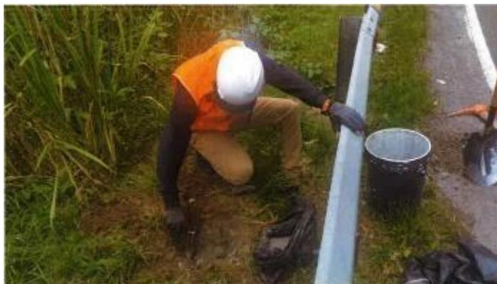
Figura N° 6: Vista de la monumentación de BMs en la margen izquierda del río, al lado de la vía Oxapampa - Paucartambo.
