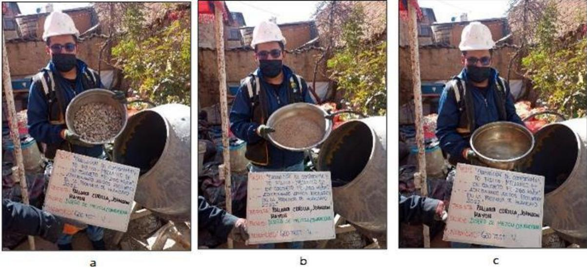
Fotografía N° 7: a) agregado grueso. B) agregado fino, c) agua y cemento
