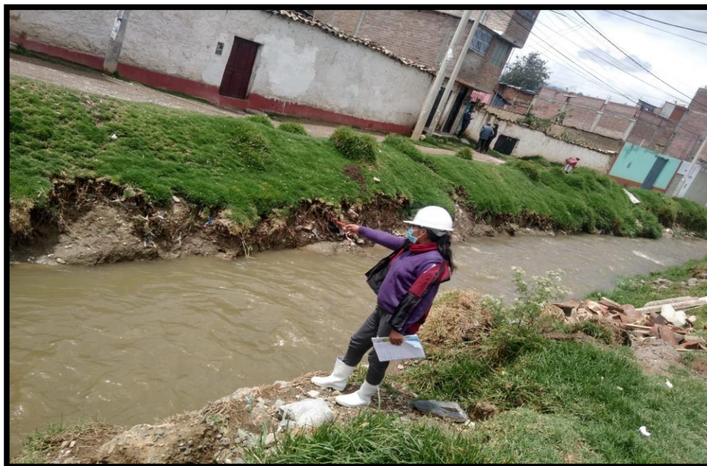
Figura 18 socavación del talud a causa del crecimiento del caudal del río
