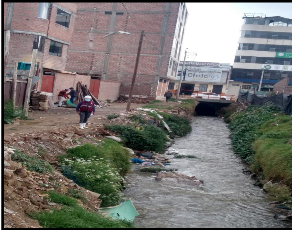
Figura 18 socavación del talud a causa del crecimiento del caudal del río
