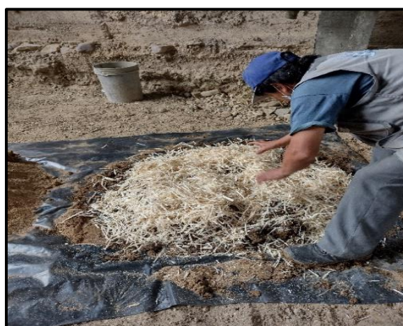
Figura 3. 86 Mezclar la fibra natural de caña de azúcar con la tierra.
