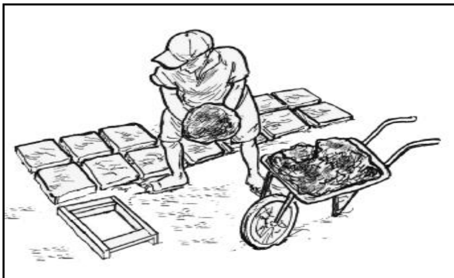
Figura 2. 8 Preparación del adobe.
