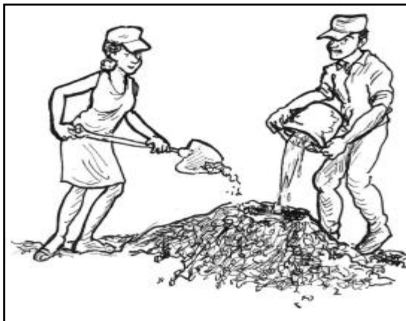
Figura 2. 6 Preparación del adobe.
