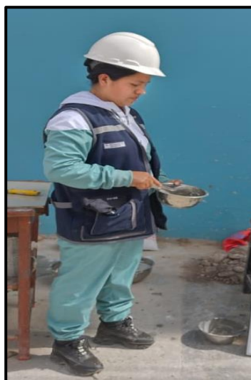
Figura 3. 104 Preparación del yeso con agua, para la realización del recapeo.
