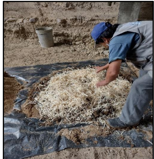
Fotografía 15. Mezcla de la tierra con la fibra de caña de azúcar.
