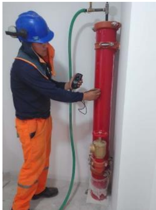
Figura 65. Prueba de espesor de pintura de las tuberías.
