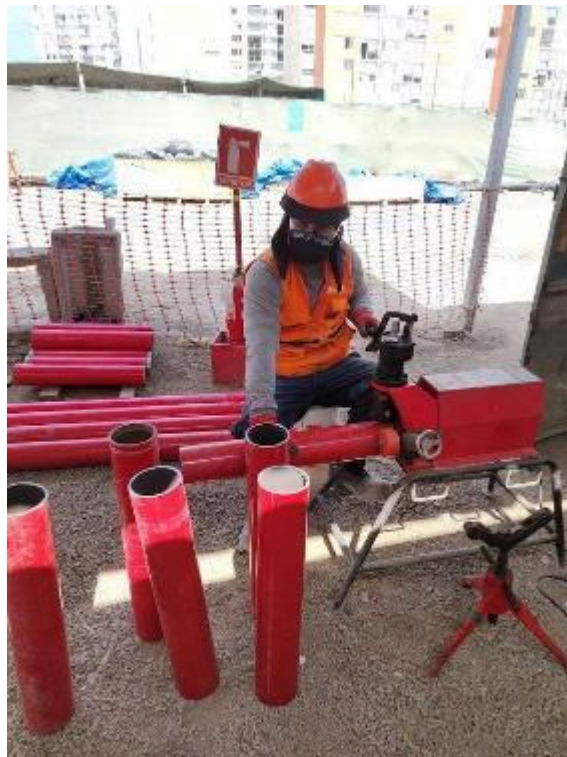
Figura 57. Ranurado y roscado de tuberías SCH-40.
