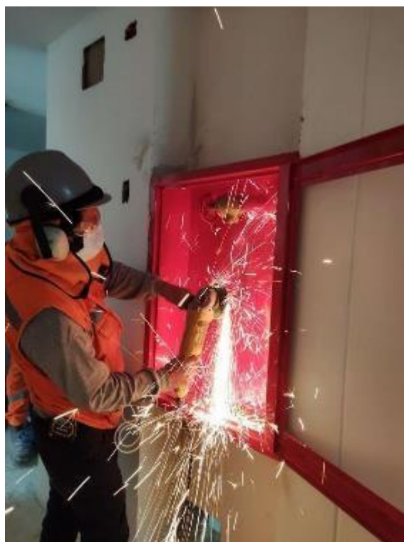
Figura 68. Instalación de gabinetes.
