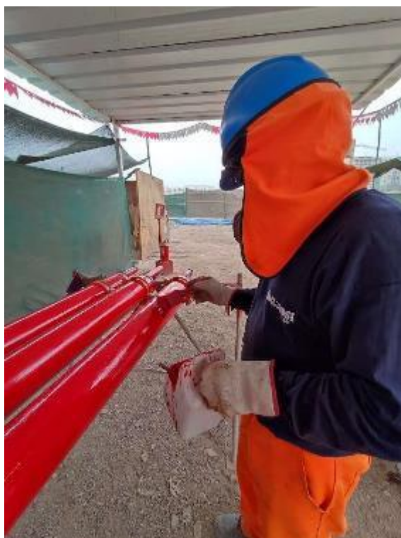
Figura 61. Pintado de tuberías SCH-40.
