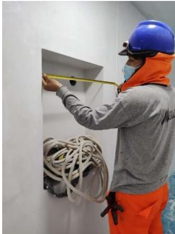
Figura 54. Medición para gabinetes.
