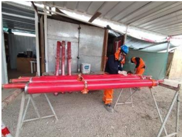
Figura 60. Instalación de acoples ranurados y roscados.
