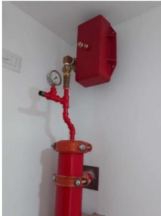
Figura 72. Instalación de Válvula de Purga Potter.
