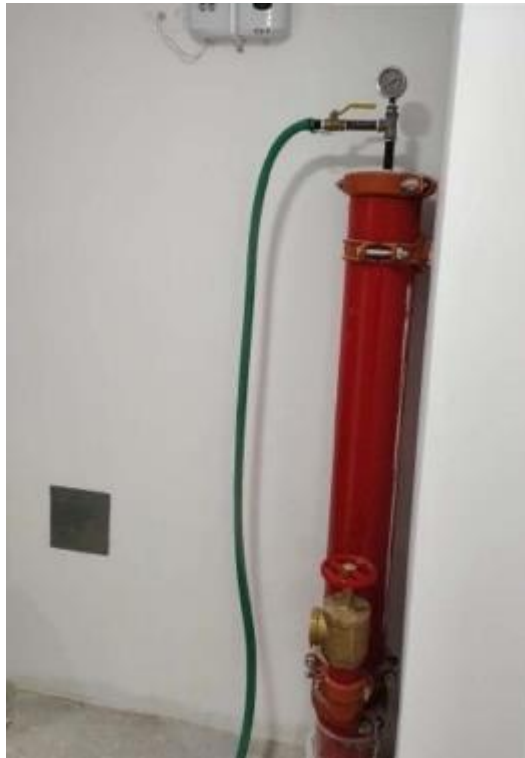
Figura 66. Prueba de Flushing.
