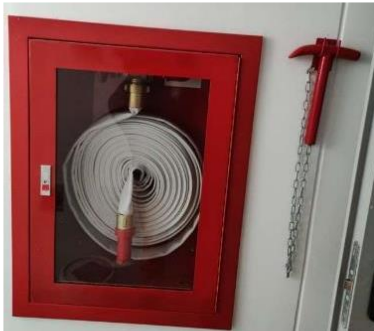
Figura 73. Instalación de manguera y accesorio de rotura del gabinete.
