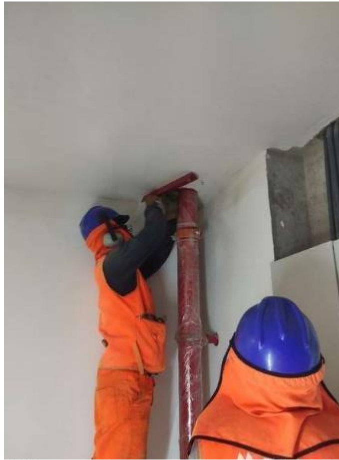
Figura 64. Instalación del montante del SCI.
