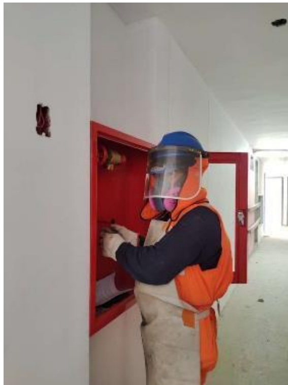
Figura 69. Ajuste de las válvulas angulares.
