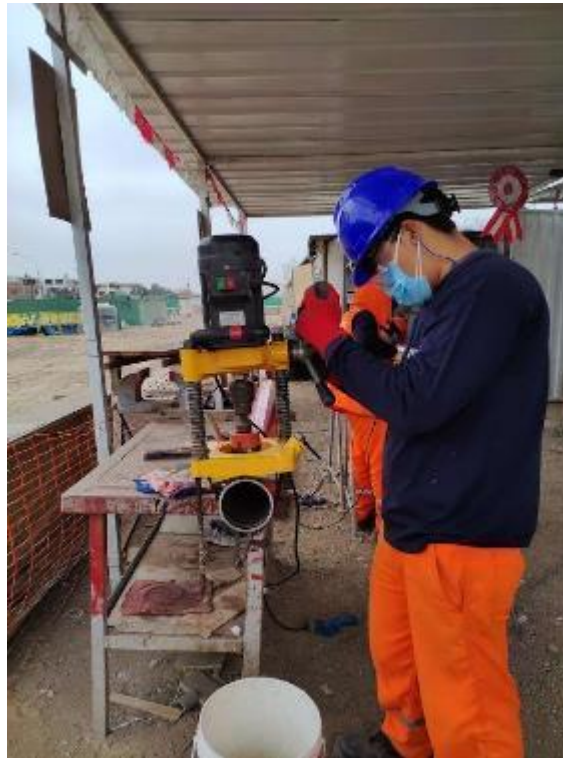
Figura 58. Perforado de tuberías SCH-40.
