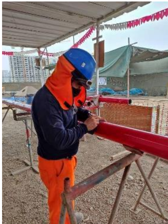
Figura 55. Trazo de medidas en las tuberías SCH-40.
