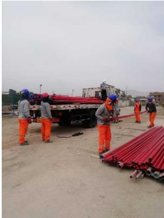
Figura 52. Recepción de tuberías SCH-40.
