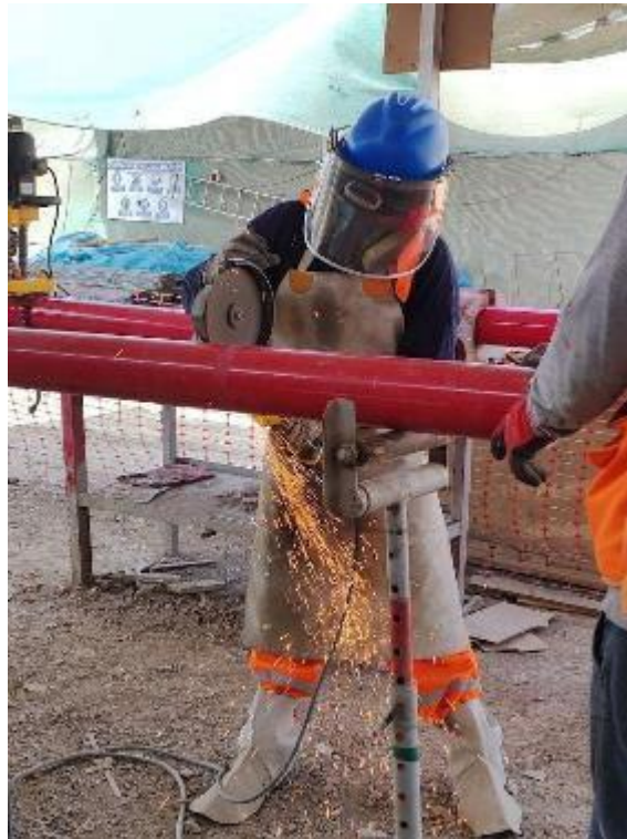
Figura 56. Corte de tuberías SCH-40.
