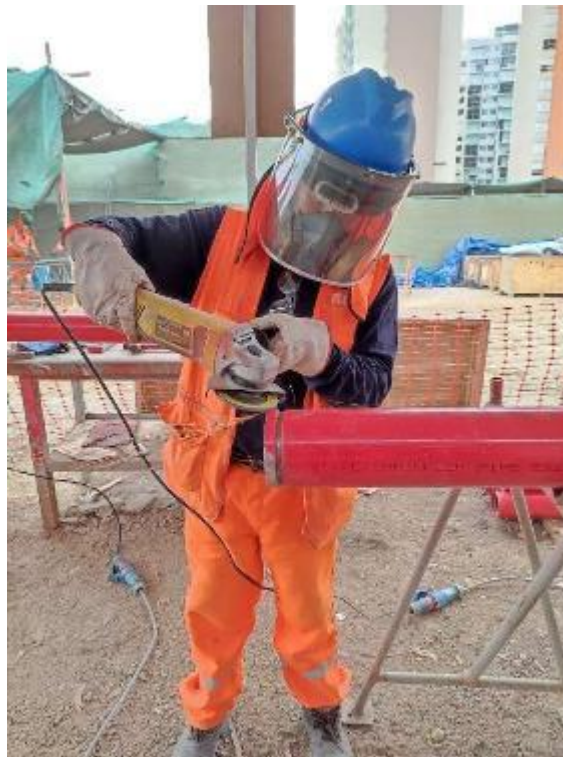
Figura 59. Lijado de los bordes de las tuberías SCH-40.
