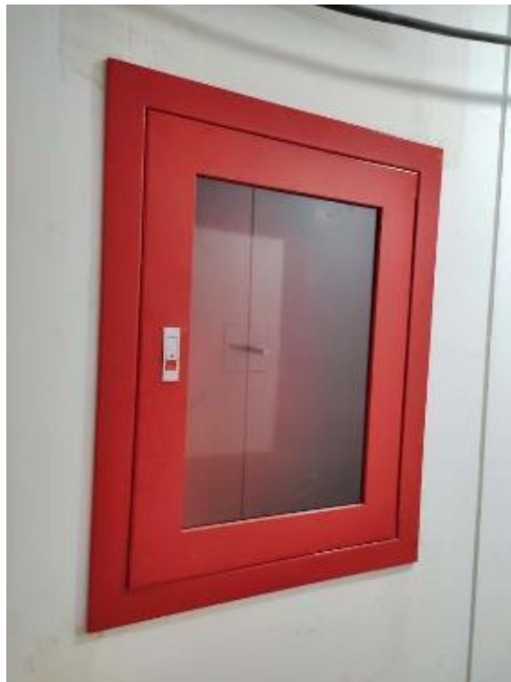
Figura 71. Instalación de vidrio templado del gabinete.
