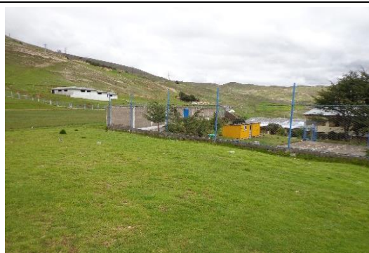
Cerco de malla olímpica deteriorado
