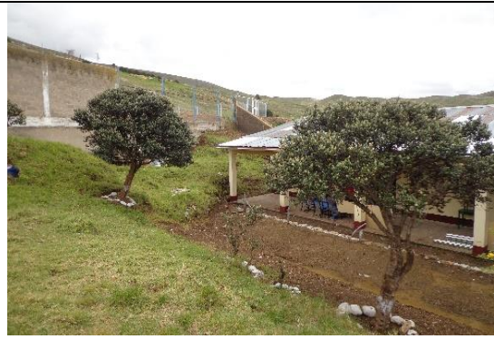
Áreas verdes sin drenaje en desnivel
