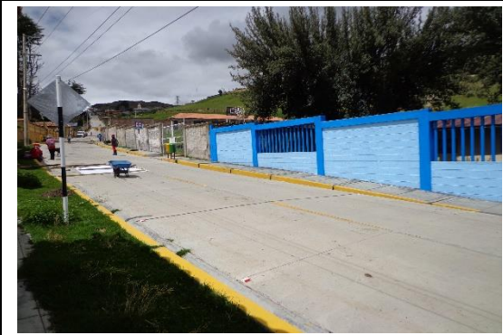
Cerco Perimétrico frontal de la I.E.
