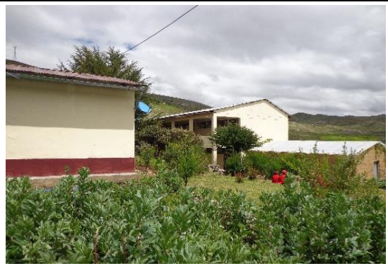
Inexistencia de áreas de circulación
