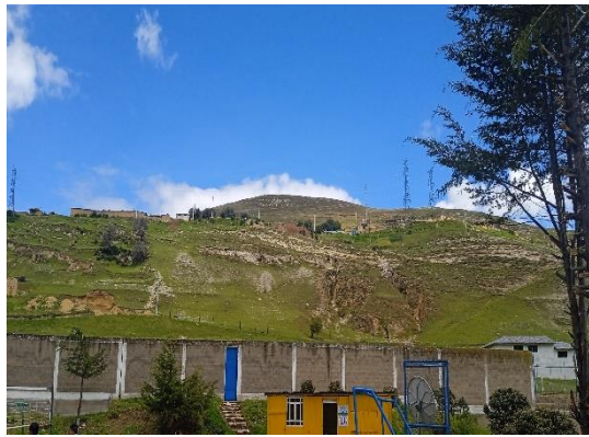
Vista de cerco parte colindante al estadio
