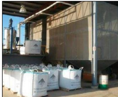
Figura 12: Realización de los casetones de elevada densidad del poliestireno expandido.
