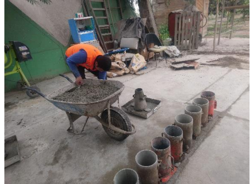
Foto 46: Determinación del slump
