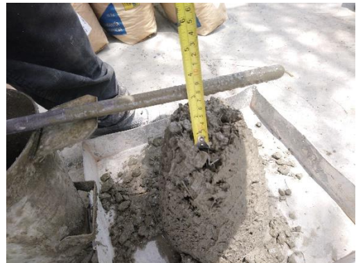
Foto 30: Determinación del slump
