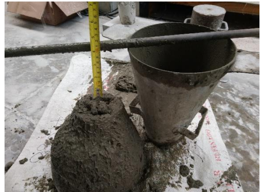
Foto 18: Medición y/o verificación del slump
