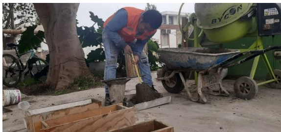
Foto 20: Determinación del slump
