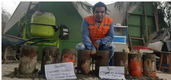
Foto 19: Elaboración de concreto
