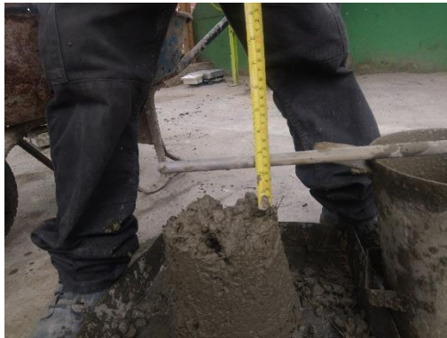
Foto 41: Medición del slump
