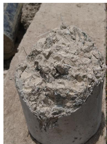
Foto 56: Detalle de las fibras en el concreto
