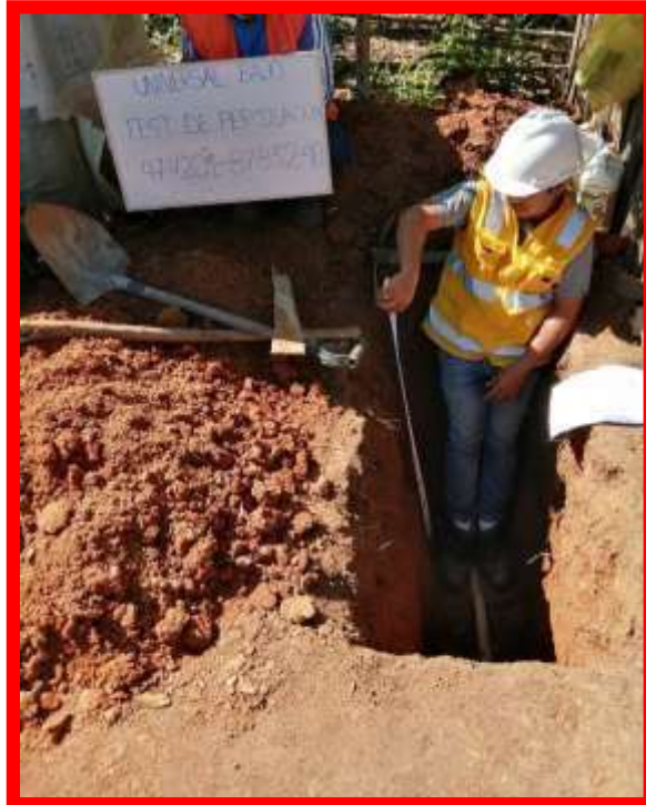
Vista Calicata, C-31.
