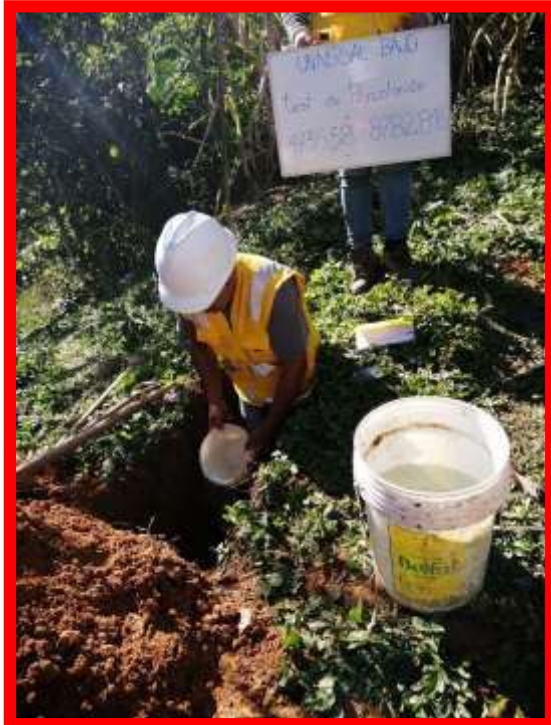
Vista Calicata, C-26.
