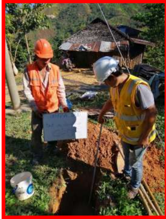
Vista Calicata, C-28.
