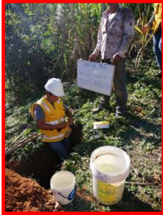
Vista Calicata, C-30.
