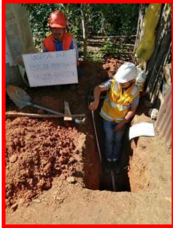
Vista Calicata, C-26.
