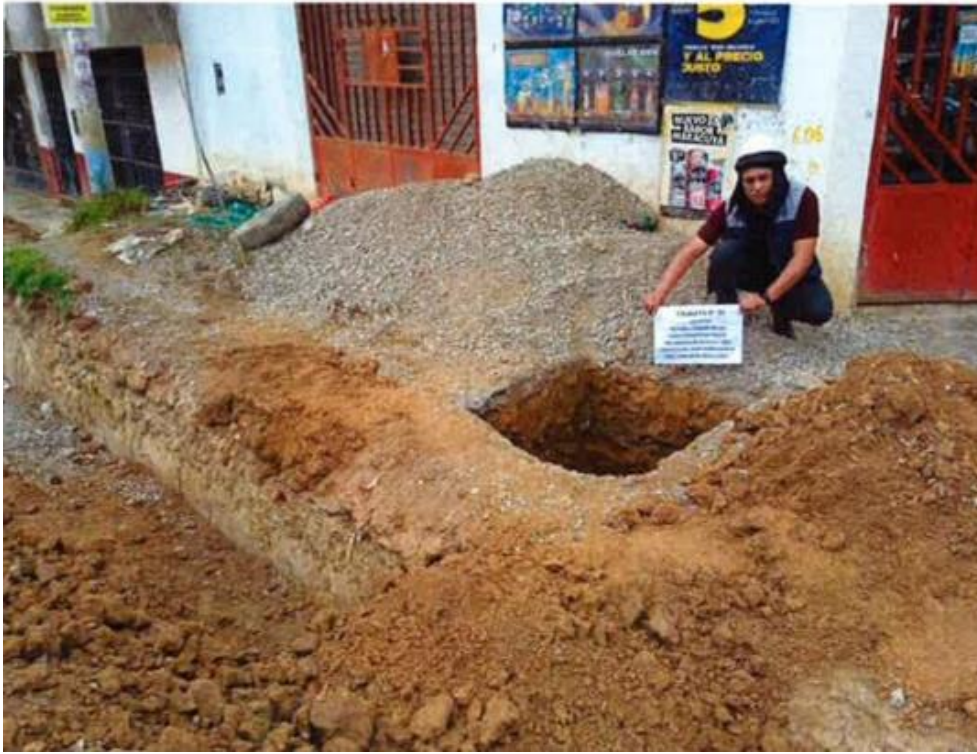
Fotografía 1. Extracción del suelo por medio de calicata.
