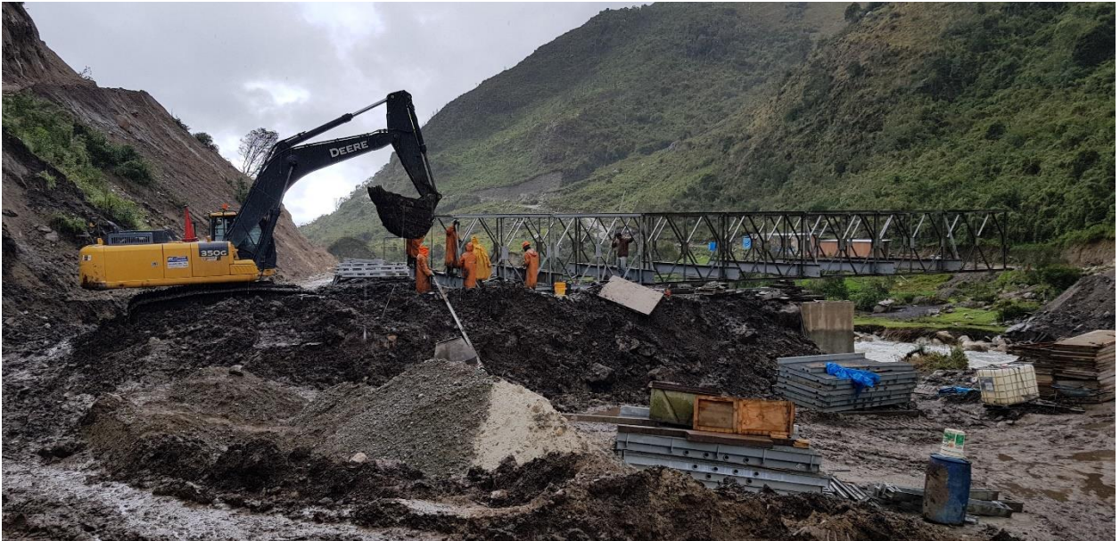
Fotografía 7. Lanzamiento del puente modular instalado
