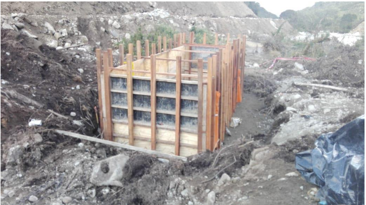
Fotografía 2. Encofrado tipo caravista de la sub estructura (Estribo y parapetos)
