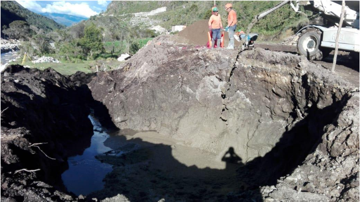
Fotografía 1. Colocado de concreto de F'c=140 \text{ kg/cm}^2 en el solado de la sub estructura
