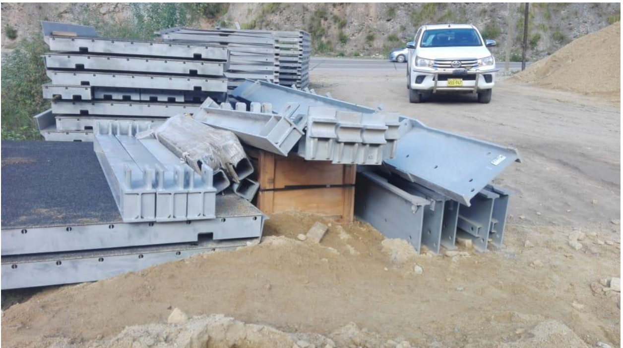
Fotografía 4. Almacenamiento de las estructuras metalizas del puente modular y de la nariz de lanzamiento
