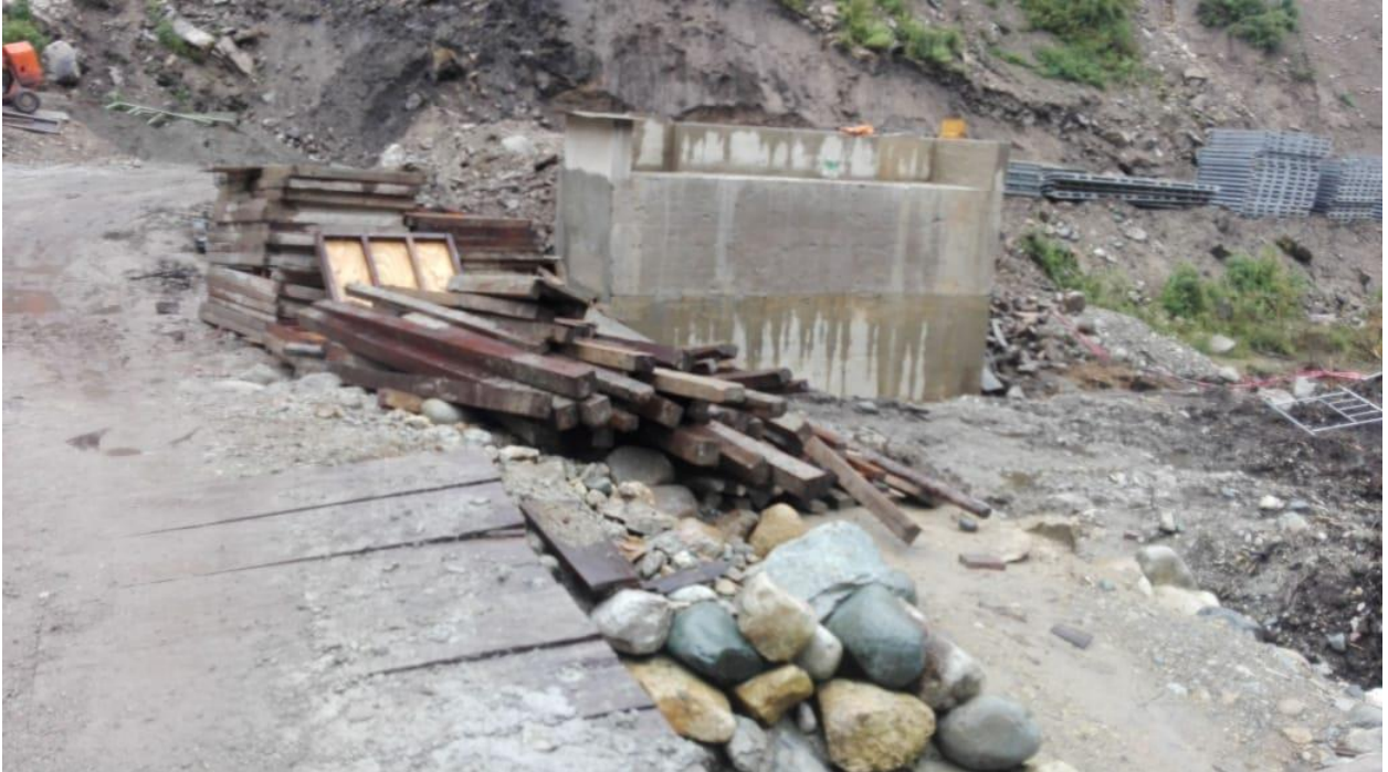
Fotografía 3. Desencofrado de la sub estructura del lado Izquierdo del puente modular
