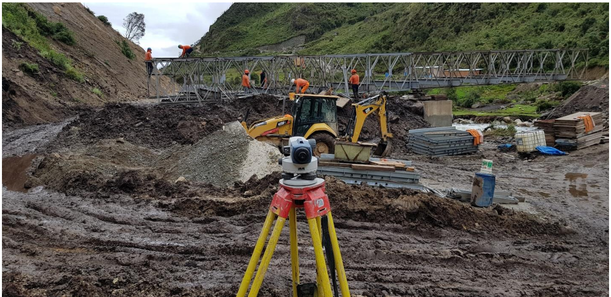
Fotografía 6. Nivelación de la estructura del puente modular, nariz de lanzamiento y cuerpo del puente (verificando los momentos para evitar el volteo de la estructura)
