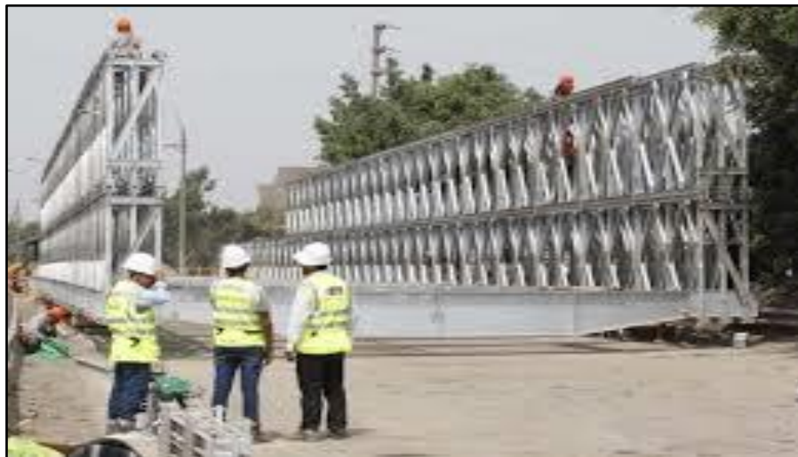
Figura 9. Montaje y lanzamiento de un puente metálico.
