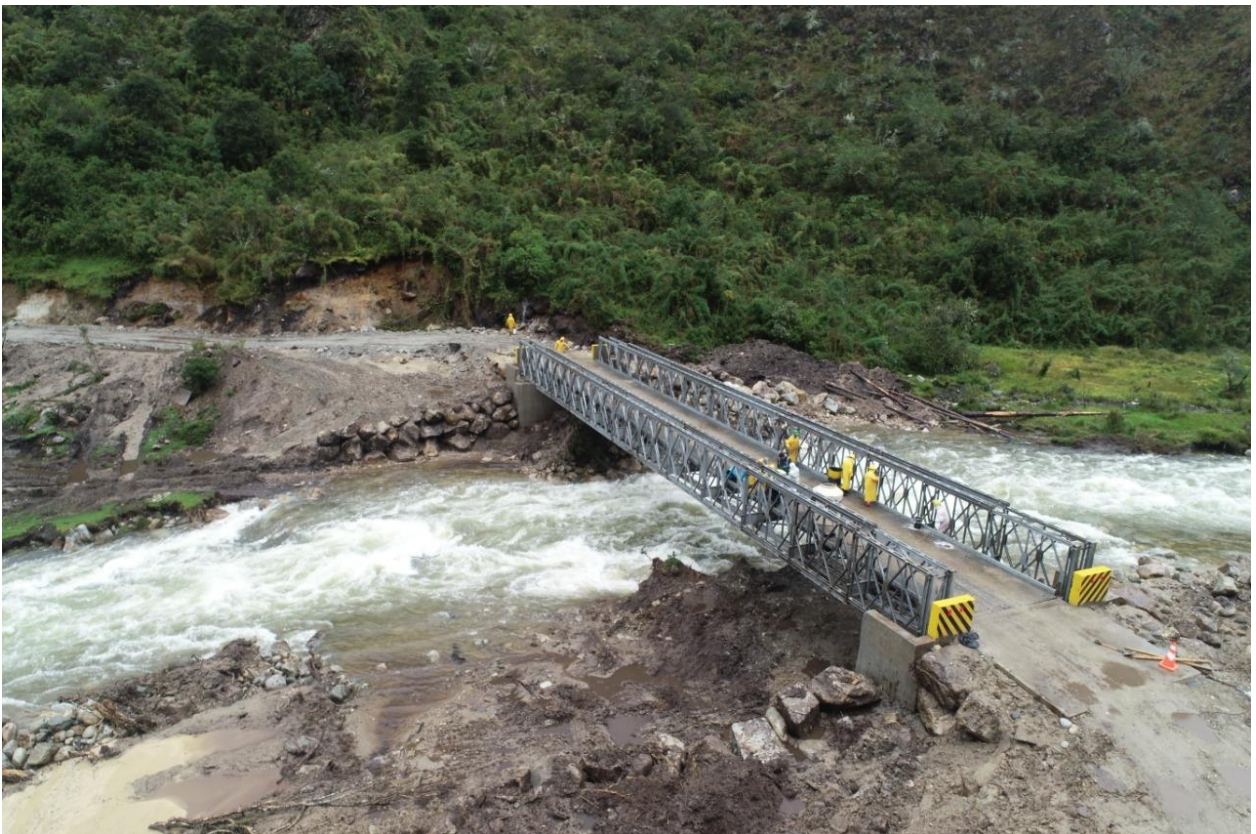
Fotografía 8. Limpieza y pintado de los muros contraimpacto del puente modular
