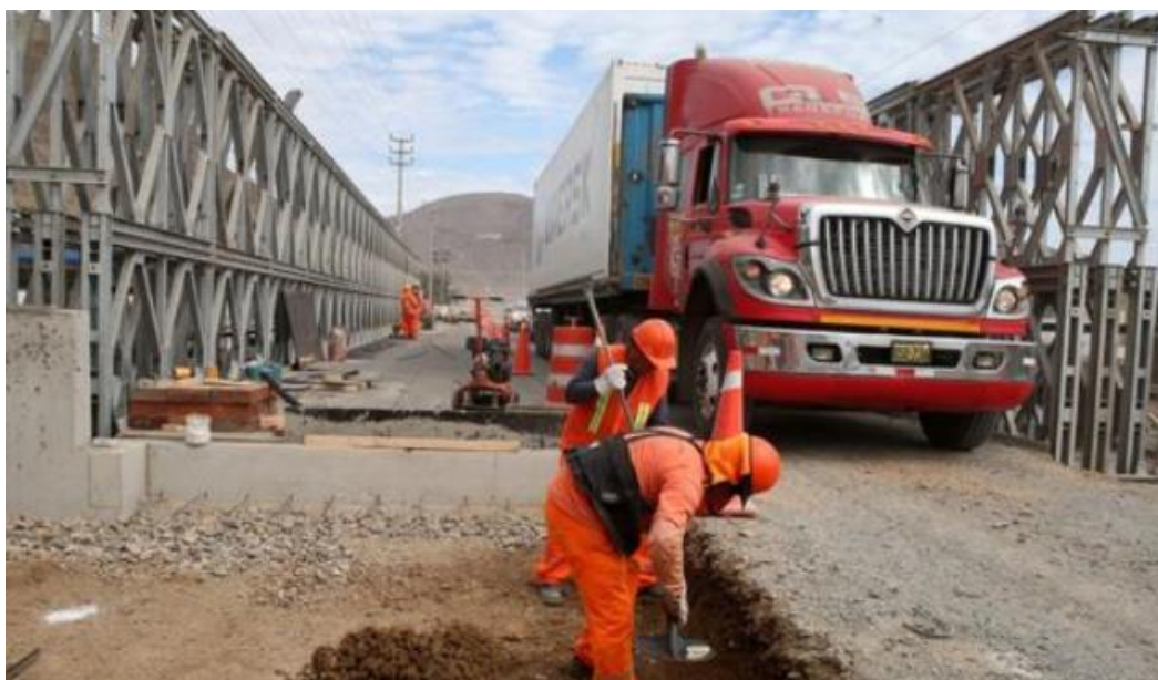
Figura 1. Puente modular en Ancash y la Libertad
