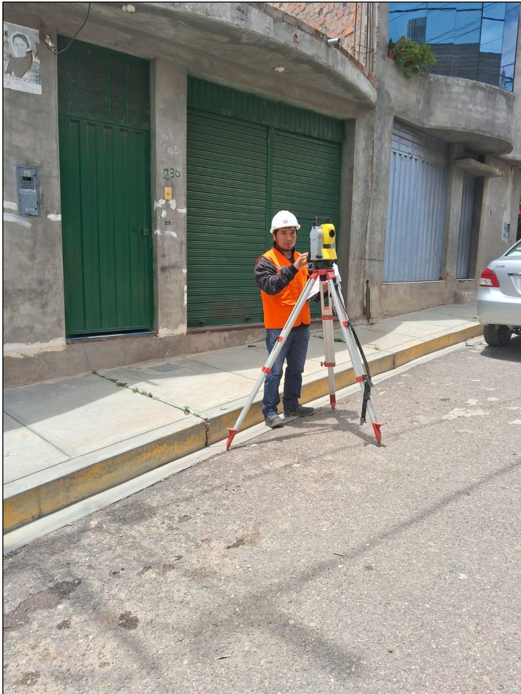
Fotografía 1. Realizando el levantamiento topográfico.
