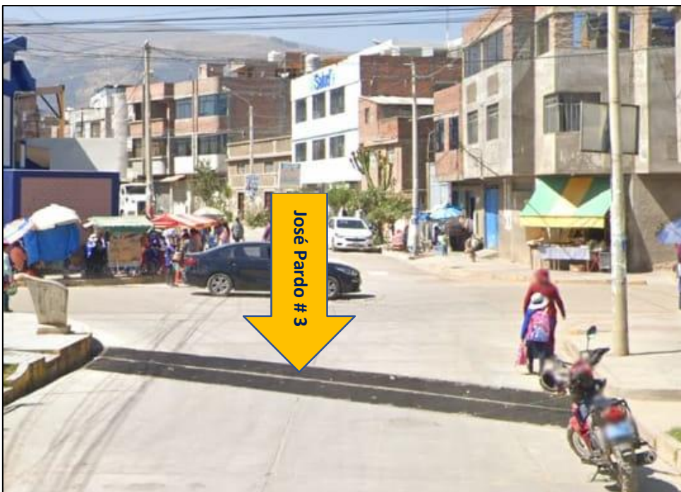
Figura 5-1. Rejilla de la cuadra 3 del Jirón José Pardo
