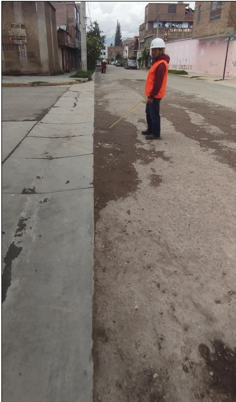
Fotografía 2. Realizando la inspección visual del daño superficial de la carpeta asfáltica.
