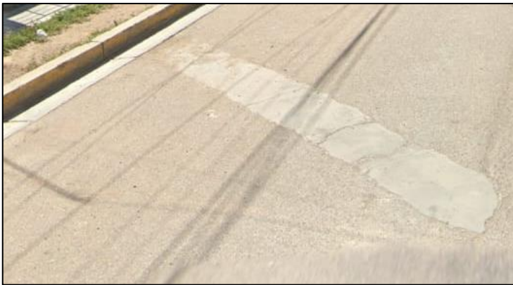
Figura 5-3. Zanjas reparadas y baches Fuente: (Araujo 2018).
