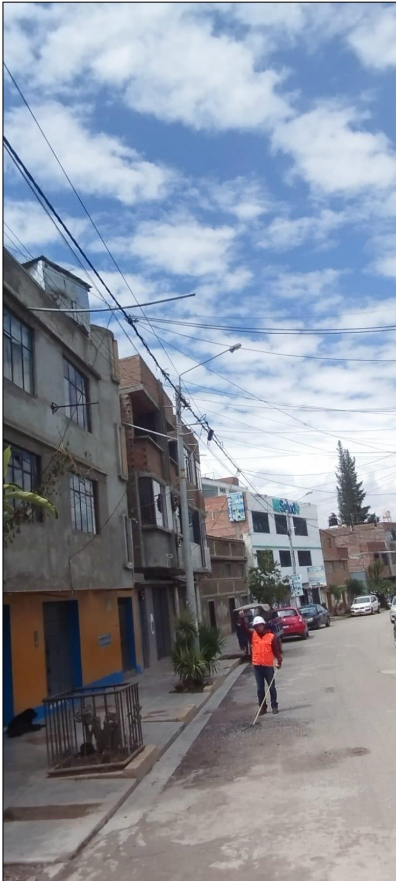
Fotografía 4 Canalización de aguas pluviales desde viviendas mediante tuberías suspendidas hacia la carpeta asfáltica.
