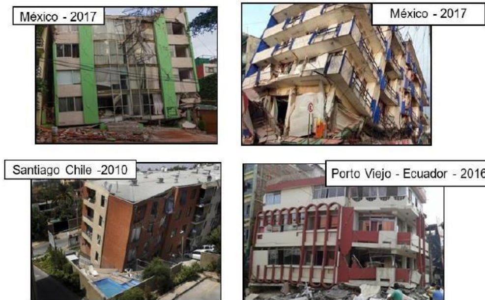
Figura 2. Colapso por piso blando en países sísmicos
