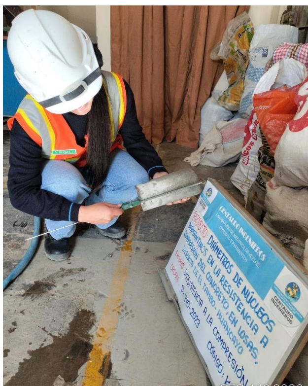
Fotografía N°16: Medición de diámetros y alturas de núcleos diamantinos 2"
