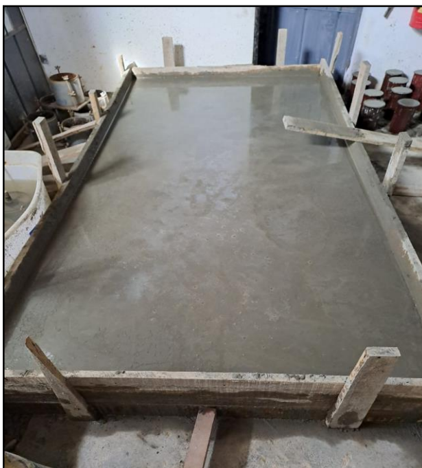
Fotografía N°7: Elaboración de losa de concreto bajo normativa E060 Concreto Armado y NTP 339.059
