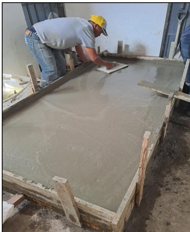
Fotografía N°6: Elaboración de losa de concreto bajo normativa E060 Concreto Armado y NTP 339.059
