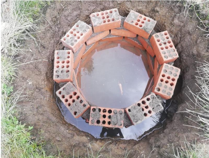
Fotografía 7. Vista del pozo de absorción 2 con ladrillos de 18 huecos.
