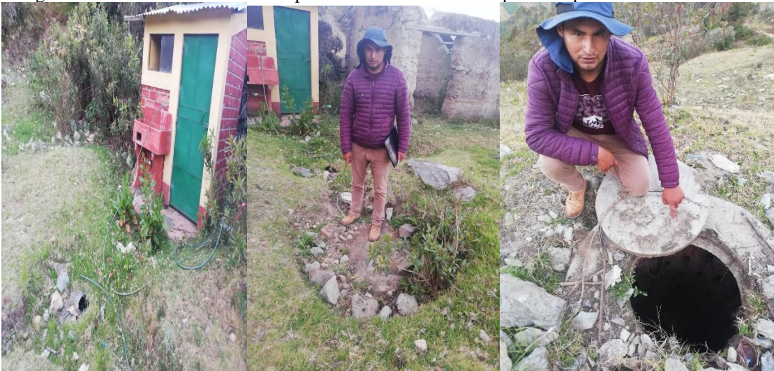
Fotografía 12. Vista de la situación actual del pozo de percolación de una vivienda.
