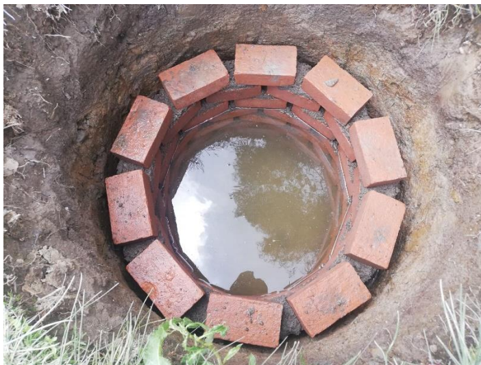
Fotografía 6. Vista del pozo de absorción 1 con ladrillos cocidos de arcilla.
