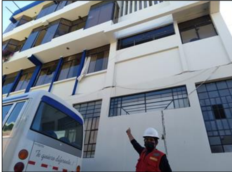
Figura N° 23. Vista posterior del palacio municipal
