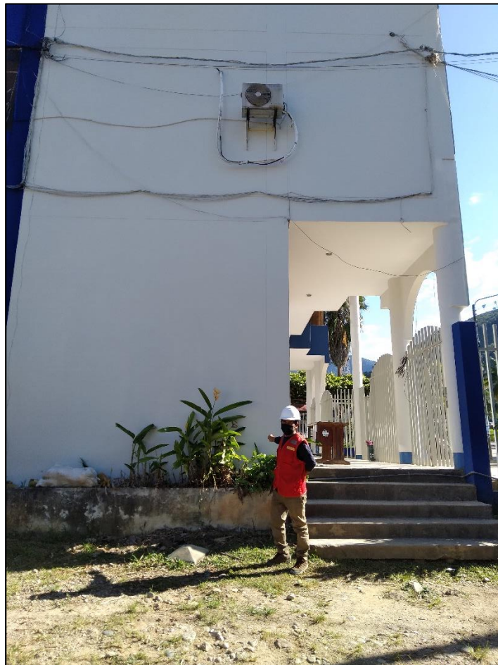
Fotografía N° 2. Elementos estructurales verticales del Palacio Municipal de Rio Negro
