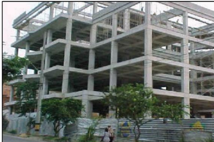
Figura N°18. Edificación con un sistema aporticado
