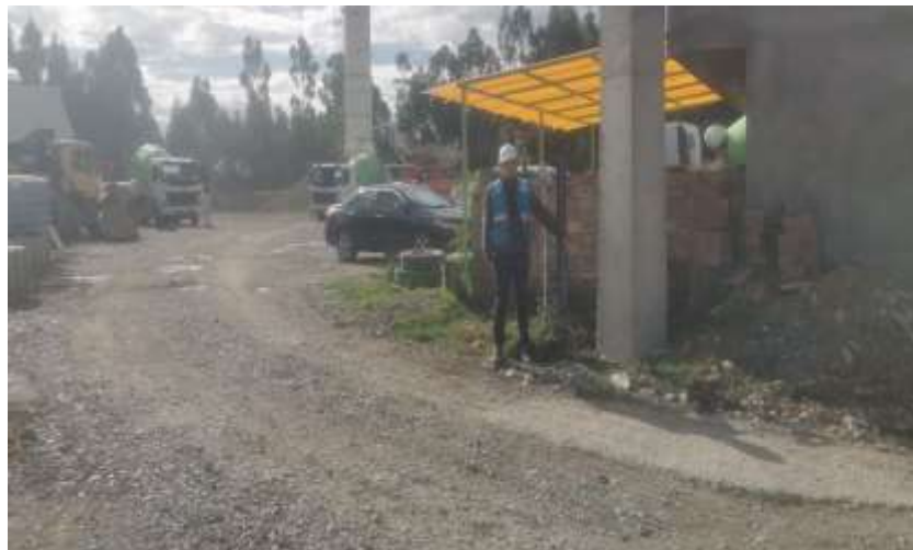
Imagen 04: Vista general de la columna desencofrada.
