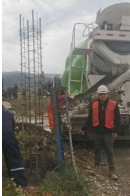
Imagen 01: Apreciación general del proceso de vaciado del concreto en los cimientos de las columnas.
