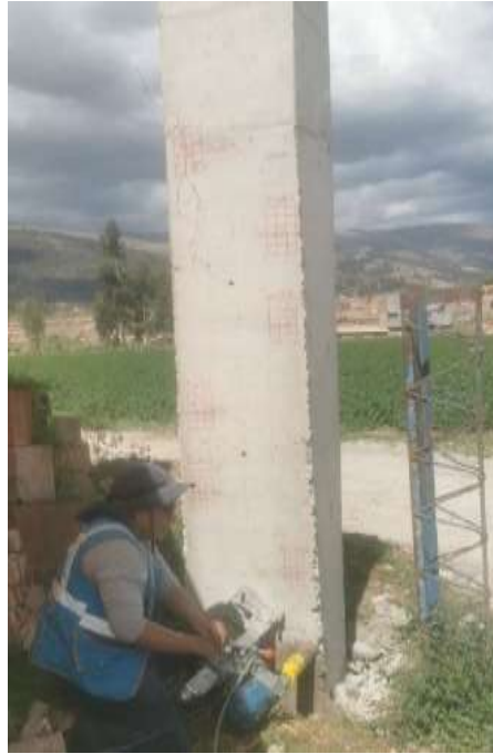
Imagen 05: Proceso de extracción de núcleos diamantinos de la columna C-1.
