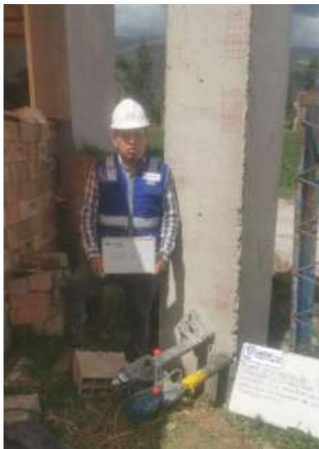
Imagen 06: Proceso de extracción de núcleos de concreto de la columna C-2.
