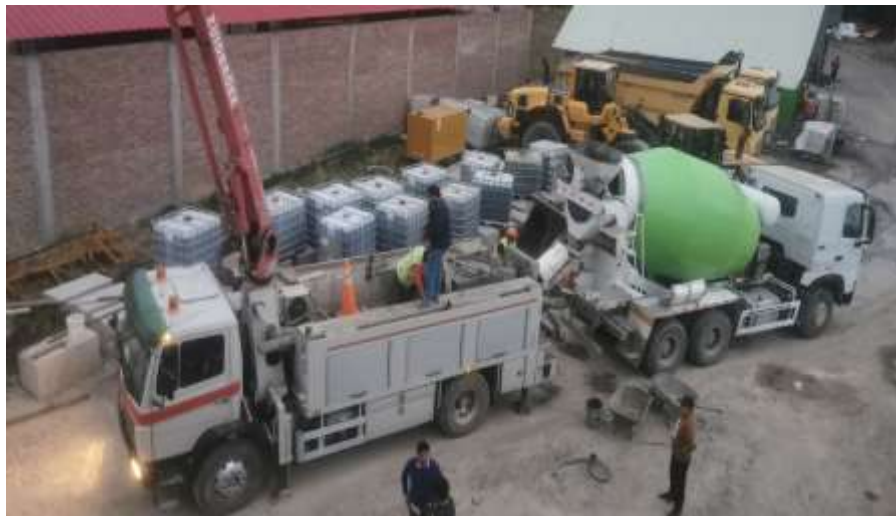
Imagen 02: Vista general del proceso de vertido del concreto en las columnas ubicadas en la Planta de Premezclado Oslo.
