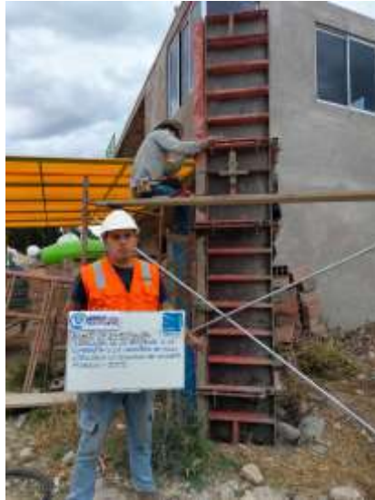
Imagen 09: Vista general del proceso de encofrado de la columna C-10.
