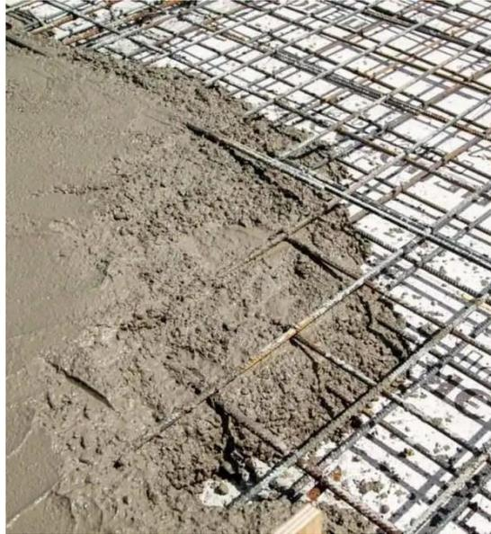
*Figura 6: Armado de losa de concreto*
