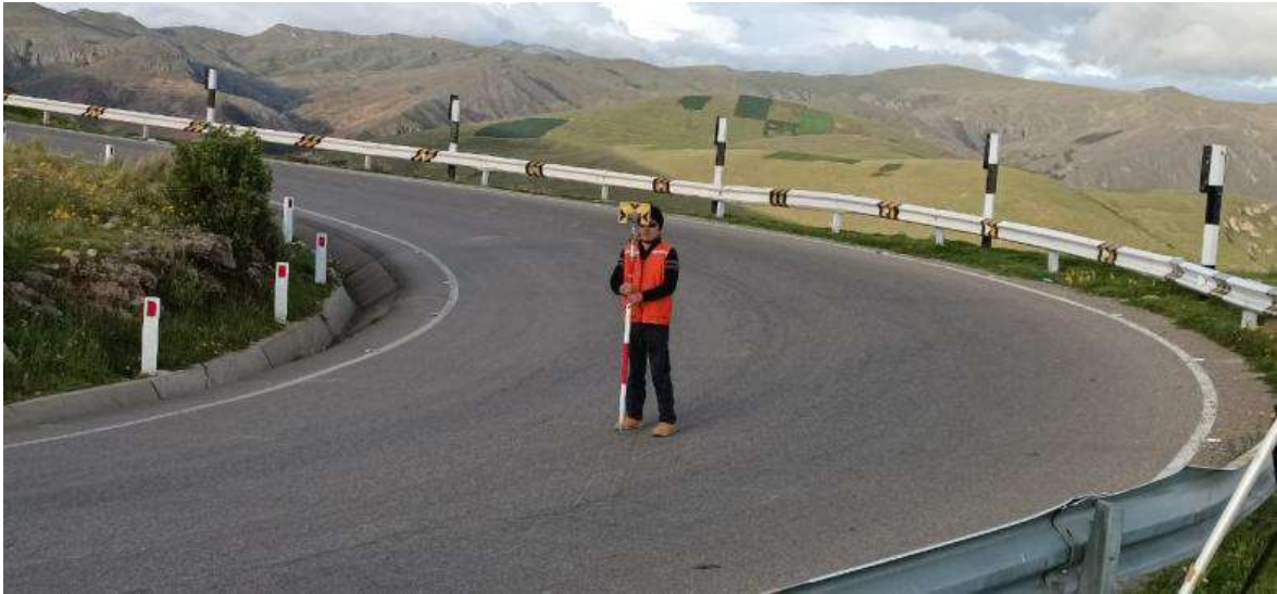
Fotografía N° 1. Levantamiento topográfico de eje de vía
