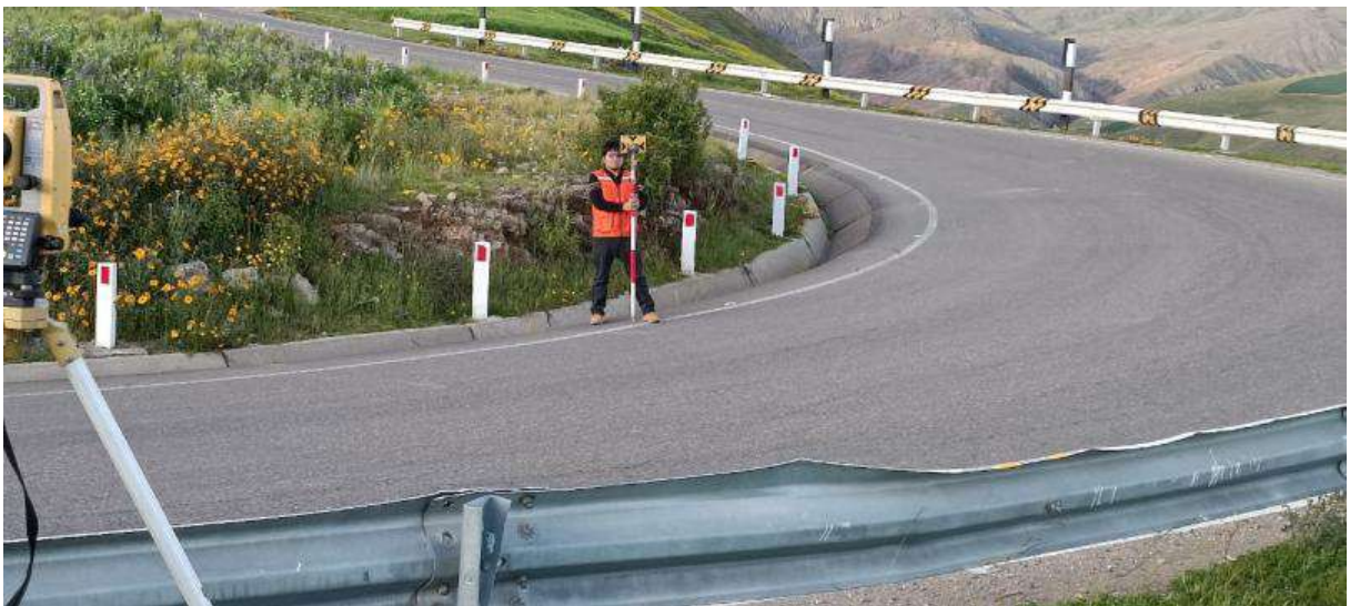
Fotografía N° 2. Levantamiento topográfico de bordes interno de vía (curva)
