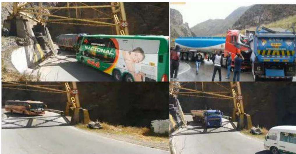
Figura 1. Evidencia de inexistencia de sobreecho en vías peruanas Fuente: (Google Earth, 2023)
