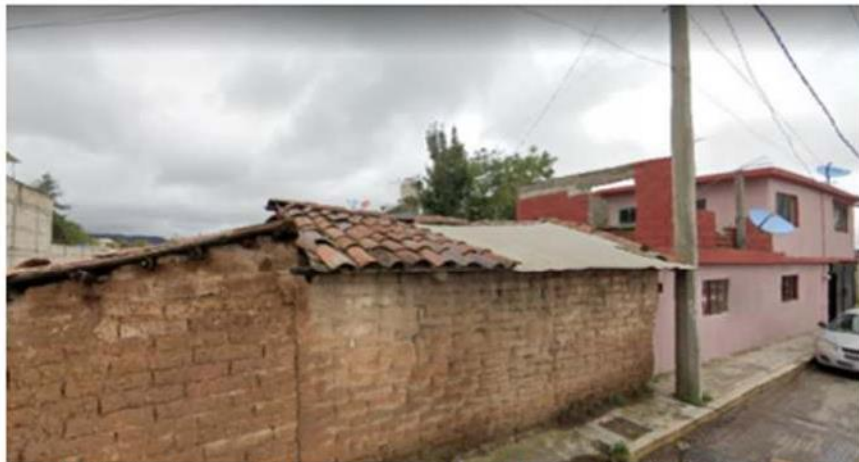
Figura 1. Vivienda vernácula con muros de adobe en Santa María Asunción, Hidalgo. Obtenida de Google maps.
