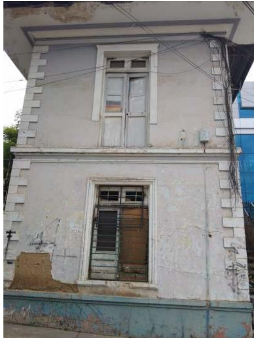
FOTO N°4: Foto de detalle del de la fachada lado izquierdo del edificio
