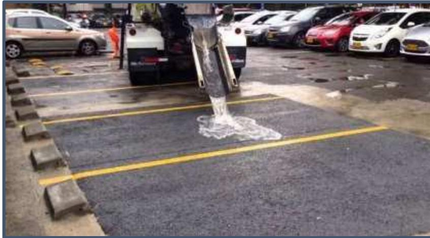
*Figura 2.5. Vía de asfalto permeable.*
