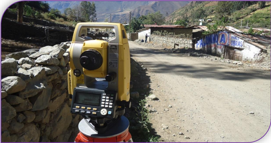
Ilustración 1: SE REALIZA EL LEVANTAMIENTO TOPOGRAFICO DE LA AV. CIRCUNVALACION
