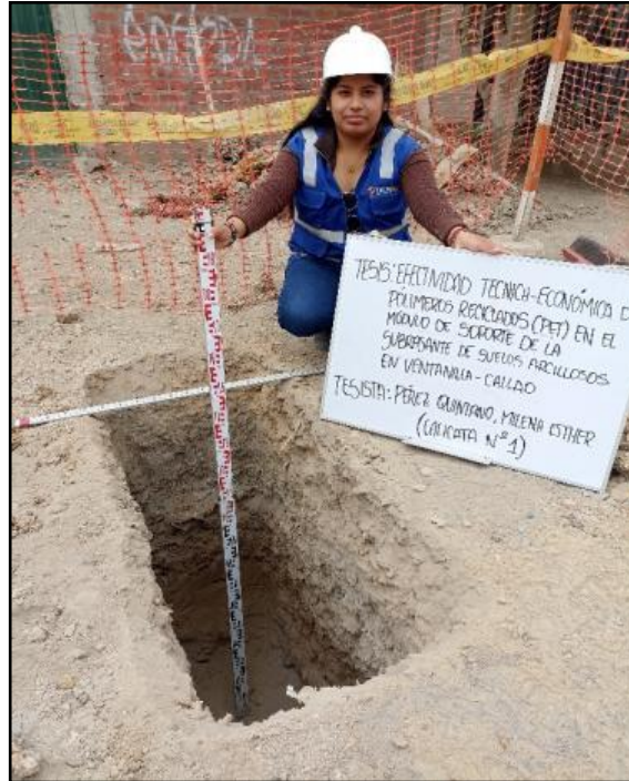
Fotografía de la calicata N°1.
