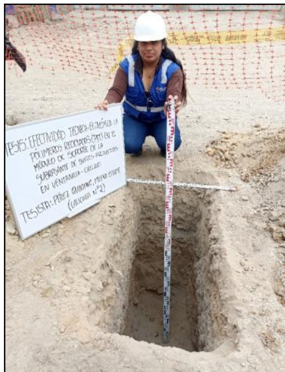
Fotografía de la calicata N°2
