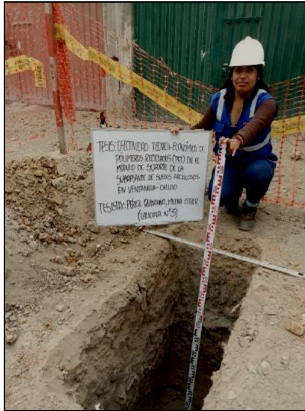
Fotografía de la calicata N°3
