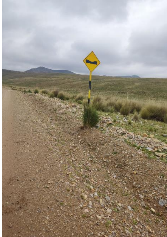
Fotografía 7: Implementación de señalización
