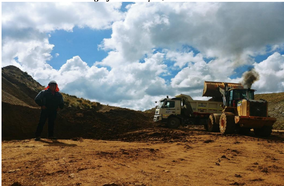
Fotografía 8: Limpieza de cantera
