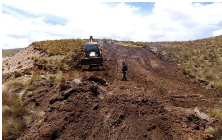
Figura 1. Limpieza y proceso de nivelación.
