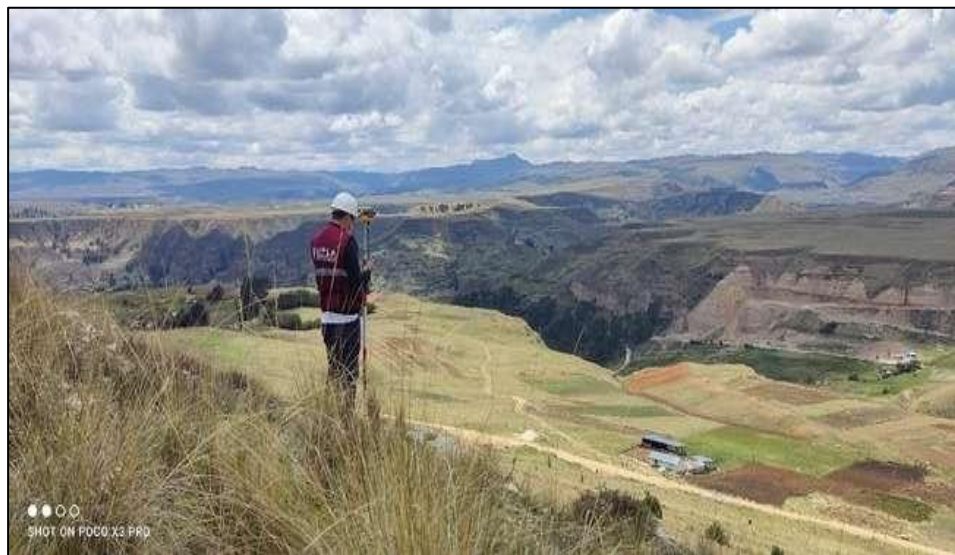
Figura 10: Lectura de BMs de poligonal.
