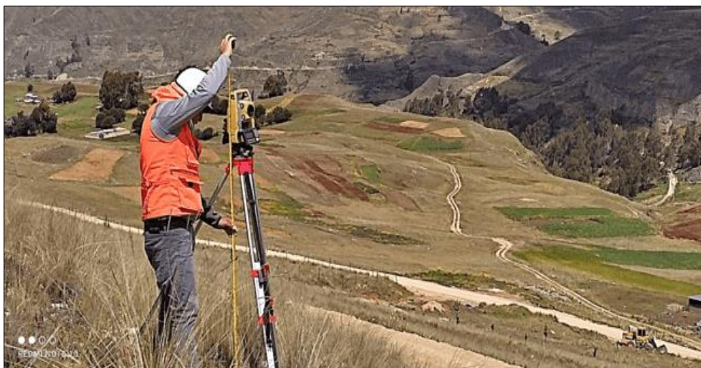
Figura 1: Camino vecinal JU 986, tramo EMP.JU 110 – EMP. JU – 986 Sector Santa Magdalena, distrito de Chicche, provincia de Huancayo.
