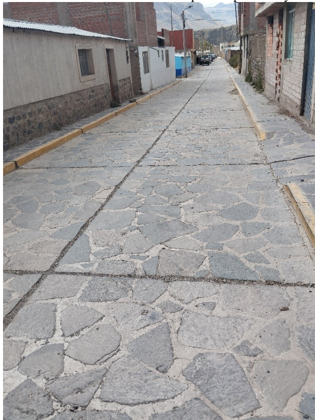
FOTOGRAFÍA 18: Visita de pavimentos existentes con piedra laja.
