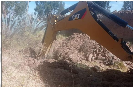
Imagen 02: Detalle de excavación Calicata C-01 Presencia de grava y arena
