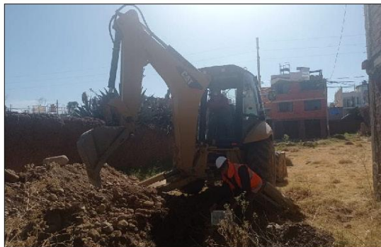
Imagen 03: Detalle de excavación Calicata C-01 Detalle de muestreo
