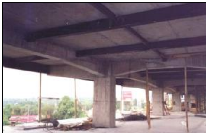
Figura 1. Edificios con traveses acarteladas de concreto reforzado en México. Fuente: Archundia y Tena (2015).
