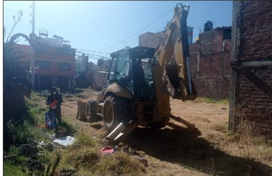
Imagen 01: Detalle de excavación Calicata C-01 Profundidad de excavación 3 metros
