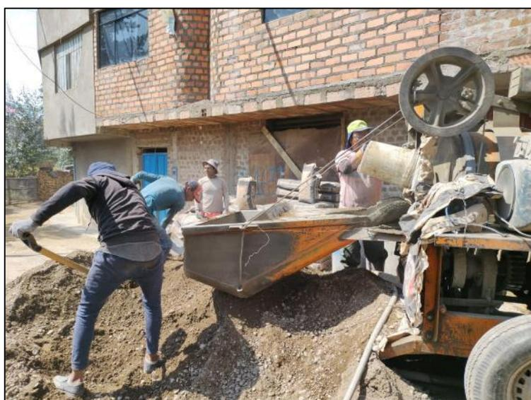
Se realizó la prueba de asentamiento, contenido de aire en 3 momentos diferentes del proceso de preparación del concreto para obtener datos representativos, el ensayo de contenido de aire, así mismo se realizó el moldeo de probetas para el registro de resistencia a compresión a 28 días. A continuación, se muestra una serie de fotografías en las que se observa la etapa durante los ensayos realizado al concreto en estado fresco.
