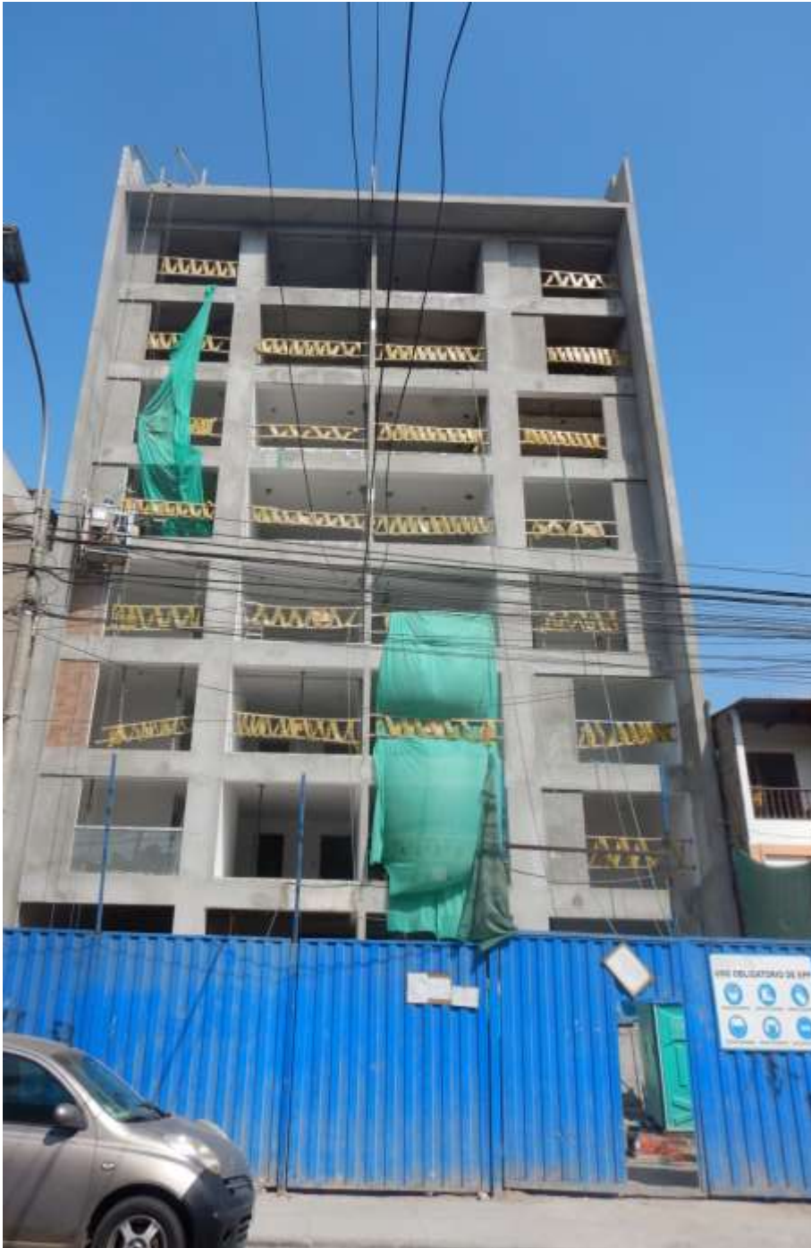
Figura 21. Estado de Fachada Principal
