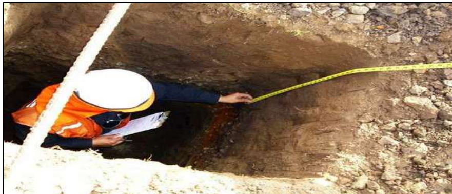
Figura 2. Estudio geotécnico con fines de cimentación
