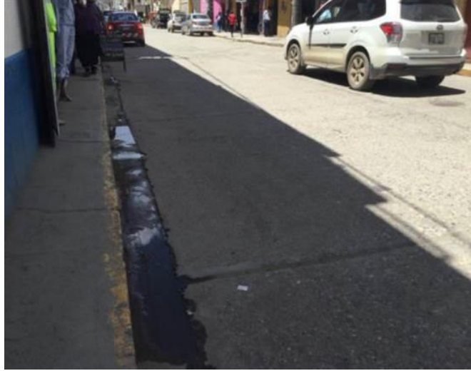
Figura 53 – Av. Ferrocarril, cruce con Jr. Cajamarca.
