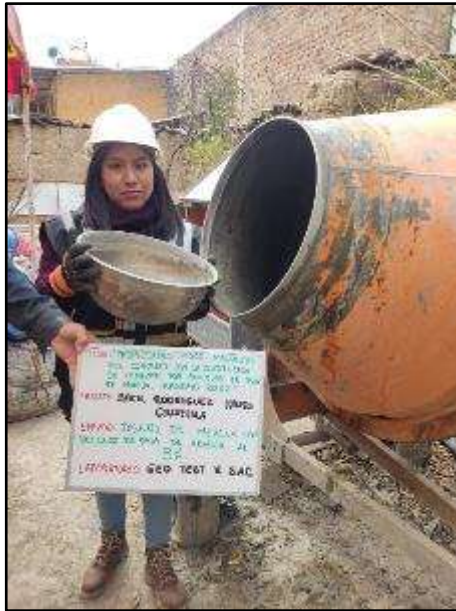
Fotografía N° 56: Incorporación del agua para la mezcla del concreto con 8% de paja de arveja
