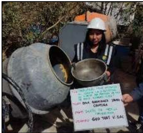
Fotografía N° 21: Incorporación del agua a la mezcladora junto a los otros materiales ya agregados
