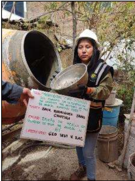
Fotografía N° 42: Incorporación de las gravas para la mezcla del concreto con 6% de paja de arveja
