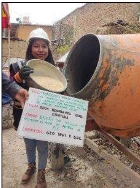
Fotografía N° 57: Incorporación de la paja de arveja con peso requerido del 8% para la mezcla del concreto
