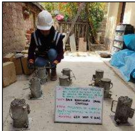
Fotografía N° 63: Preparación de testigos cilíndricos con el 8% de paja de arveja
