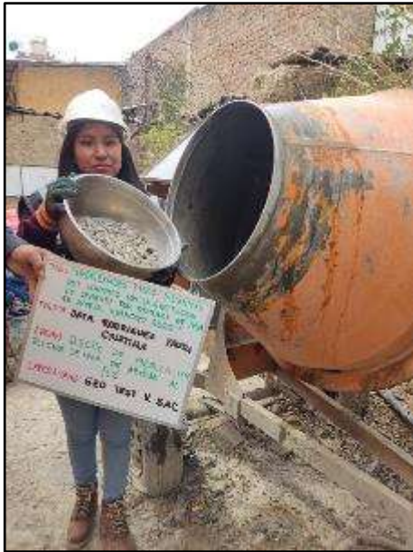
Fotografía N° 54: Incorporación de las gravas para la mezcla del concreto con 8% de paja de arveja
