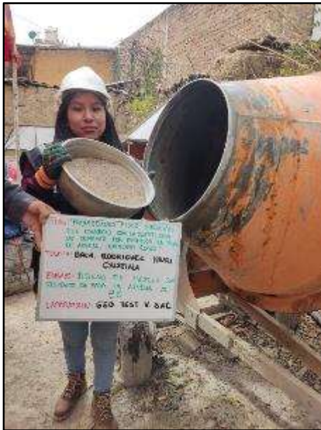
Fotografía N° 55: Incorporación de arena fina para la mezcla del concreto con 8% de paja de arveja
