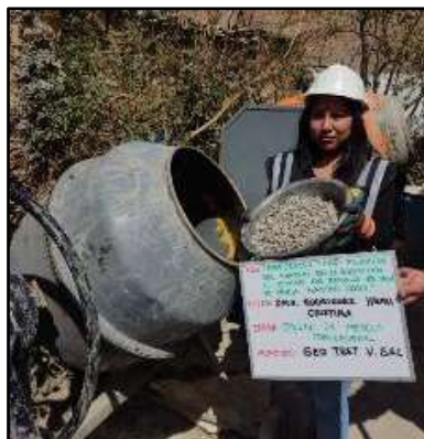
Fotografía N° 19: Incorporación de las gravas a la mezcladora
