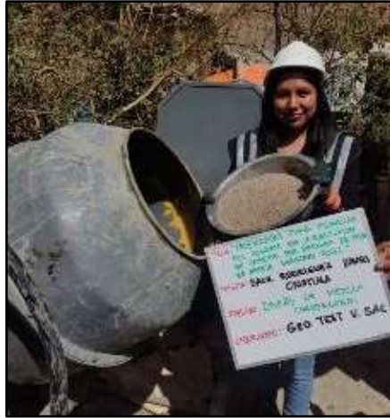
Fotografía N° 20: Incorporación del agregado fino a la mezcladora
