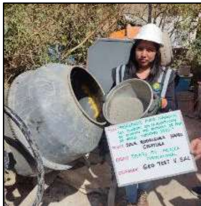
Fotografía N° 18: Incorporación del cemento a la mezcladora
