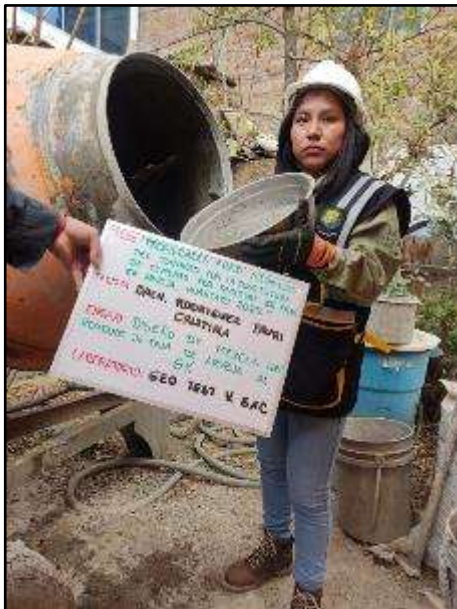
Fotografía N° 41: Incorporación de cemento para el concreto con 6% de paja de arveja
