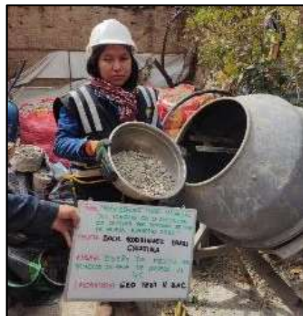
Fotografía N° 30: Incorporación de las gravas para la mezcla del concreto con 4% de paja de arveja
