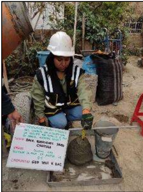
Fotografía N° 47: Medida del asentamiento de concreto fresco usando 6% de paja de arveja
