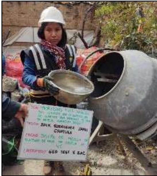
Fotografía N° 32: Incorporación del agua para la mezcla del concreto con 4% de paja de arveja.
