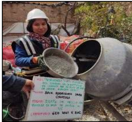
Fotografía N°29: Incorporación de cemento para el concreto con 4% de paja de arveja
