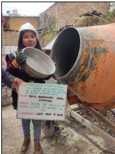
Fotografía N° 53: Incorporación de cemento para el concreto con 8% de paja de arveja
