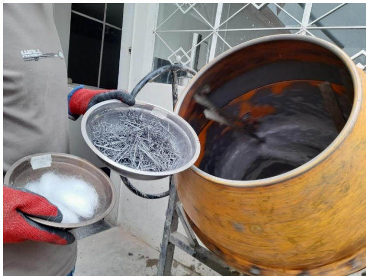
Figura 3.32. Adición del aditivo Aircon Z a la mezcla de concreto.
