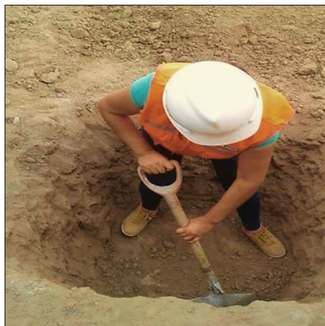
Figura 11. Exploración de las calicatas.
