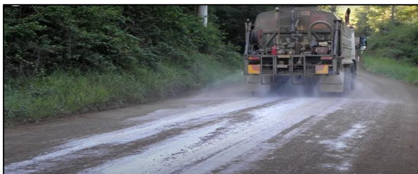
Figura 4. Pulverización de polímero Acrílico AggreBind. Fuente: (AggreBind, 2014)
