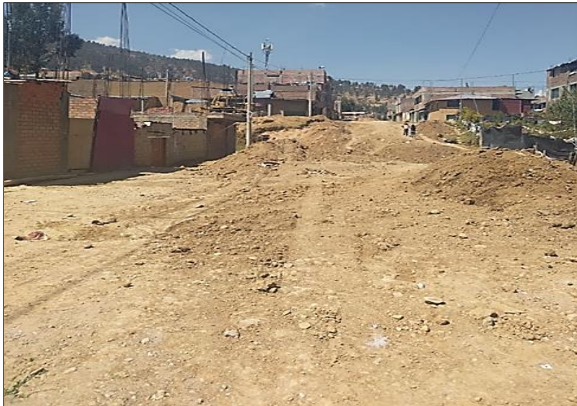
Figura 1. Vista del Jr. los Álamos, subrasante compuesta de suelos arcillosos. Fuente: Autor.
