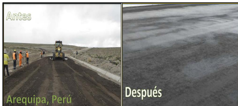
Figura 5. Estabilización con polímeros. Fuente: (AGEECOVIAS, 2022)
