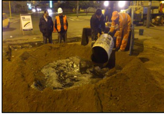
Figura 3. Polímero Acrílico AggreBind con solución de agua. Fuente: (AGEECOVIAS, 2022)
