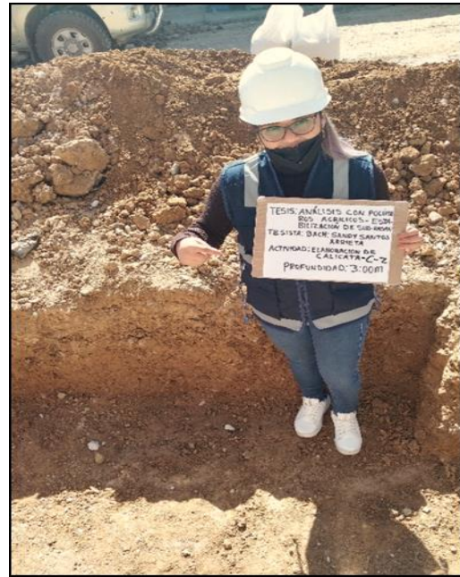
Fotografía N° 2: Exploración de calicata C-2, a 0.80m, para luego llegar a la profundidad de 3.00m.
