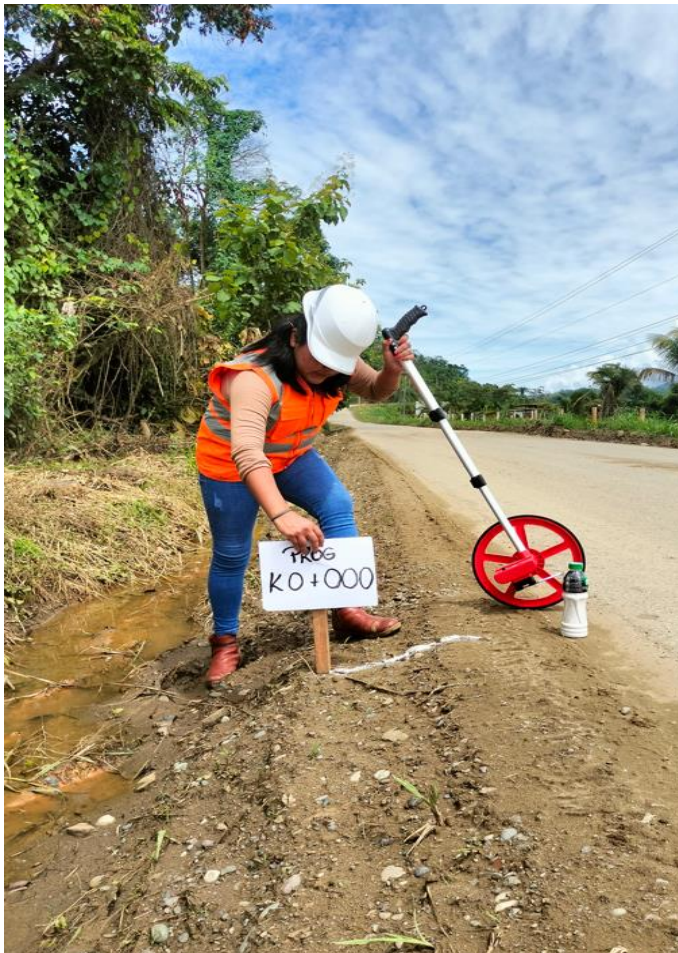
Fotografía N°03: Inicio del proceso de abscisado, para delimitar las unidades de muestra, se separa cada 100 m.
