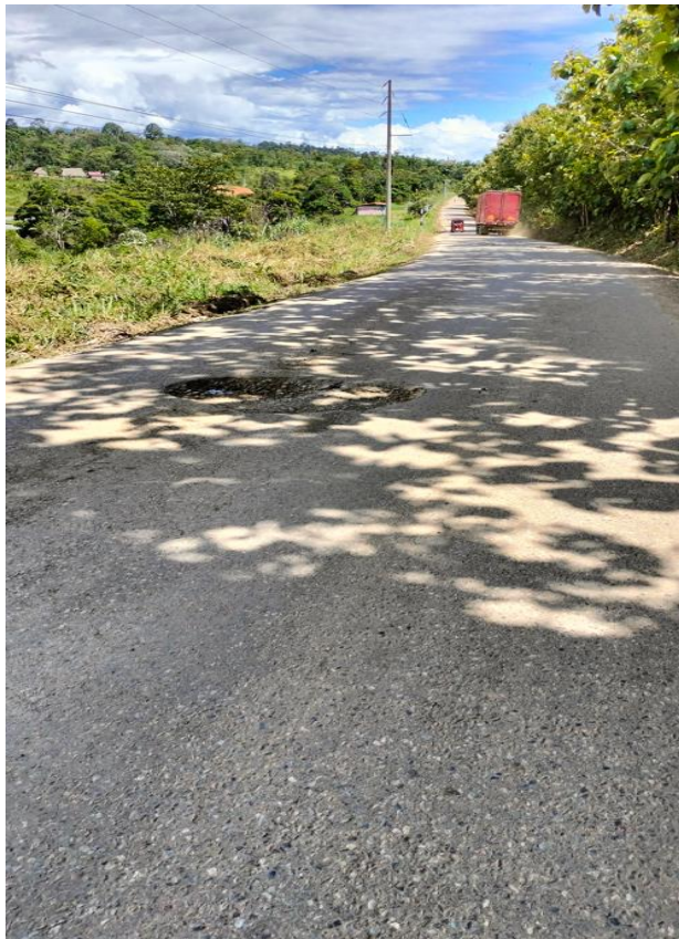
Fotografía N°01: Vista general de la carretera en estudio.
