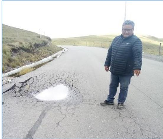
Figura 9. Agrietamiento en
