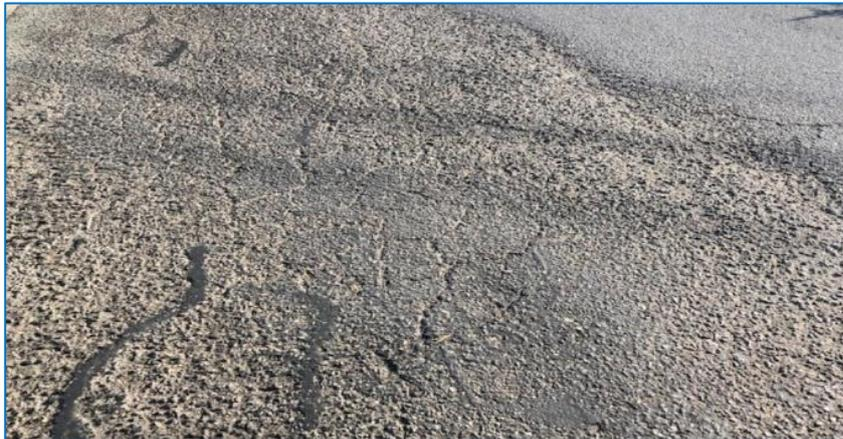
*Figura 23. Peladura y desprendimiento.
