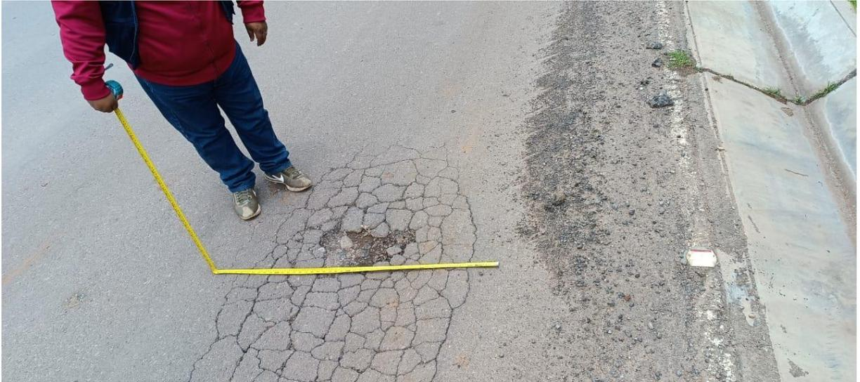
*Gráfico 9. Agrietamiento en bloque / pulimiento de agregados
