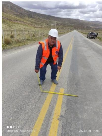
*Figura 12. Grietas transversales y longitudinales.
