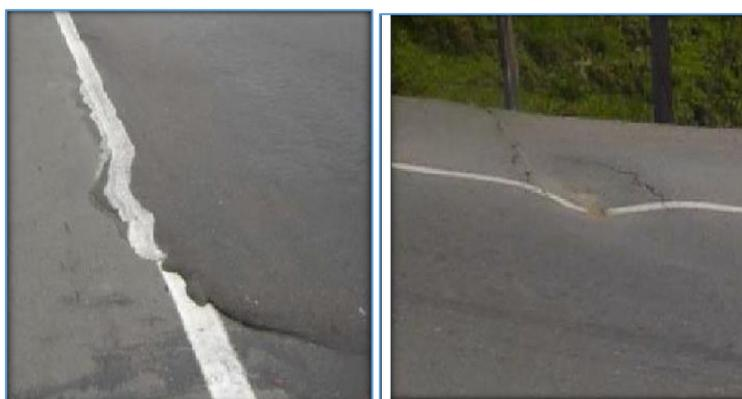
*Figura 14. Abultamientos y hundimientos
