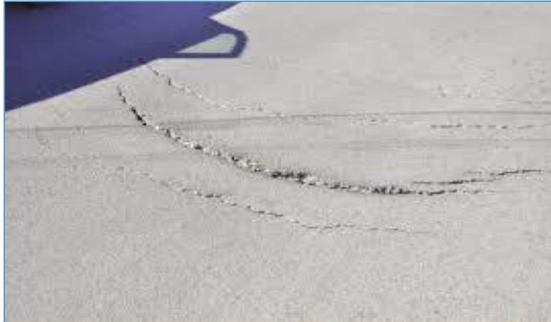
*Figura 13. Grietas parabólicas o por deslizamiento.
