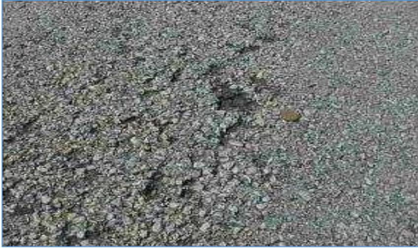
*Figura 22. Pulimiento de agregados.
