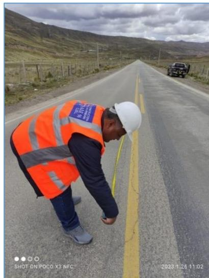
Figura 10. Grieta de reflexión de junta.
