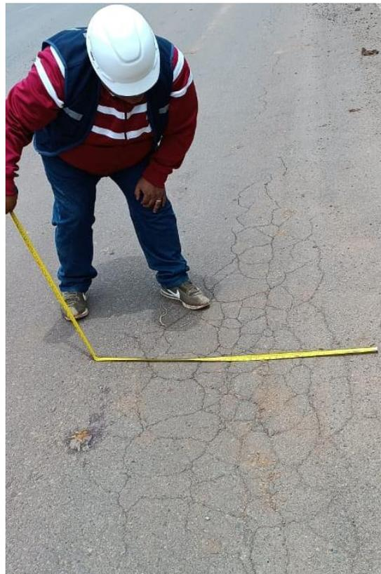
*Gráfico 8. Piel de cocodrilo / agrietamiento en bloque kilómetro 22+660, margen derecha, acceso hacia Vilcabamba.*
