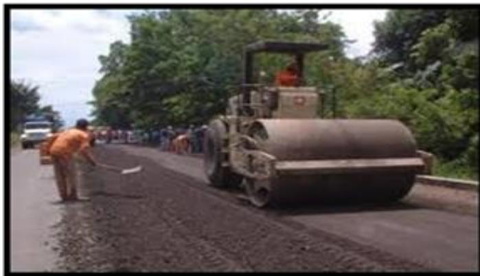
Figura 5. Conformación de la base de una vía.
