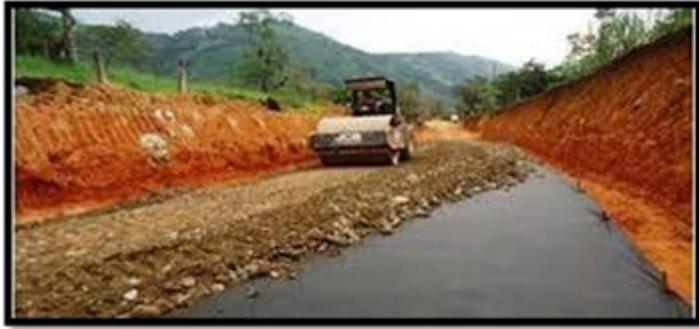
Figura 5. Conformación de la sub base de una carretera.
