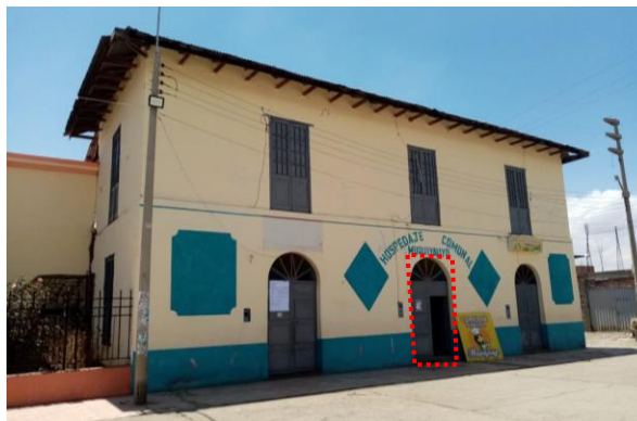
Ubicación del acceso principal al centro de la fachada
