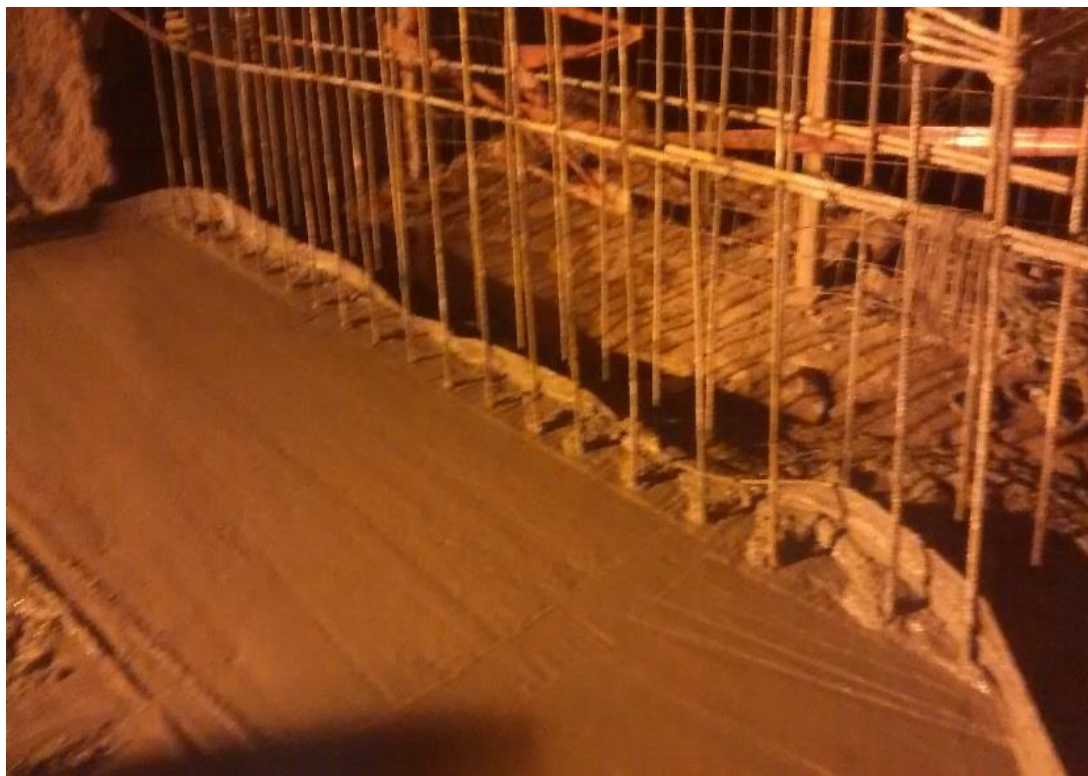
Fotografía N° 3: Vaciado de concreto armado para zapata del muro n° 01
