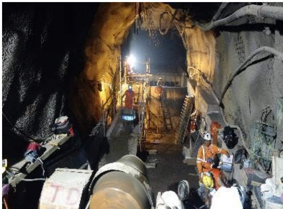
Fotografía N° 9: Vaciado de concreto para muro n° 01 de la cámara de bomba nv 100
