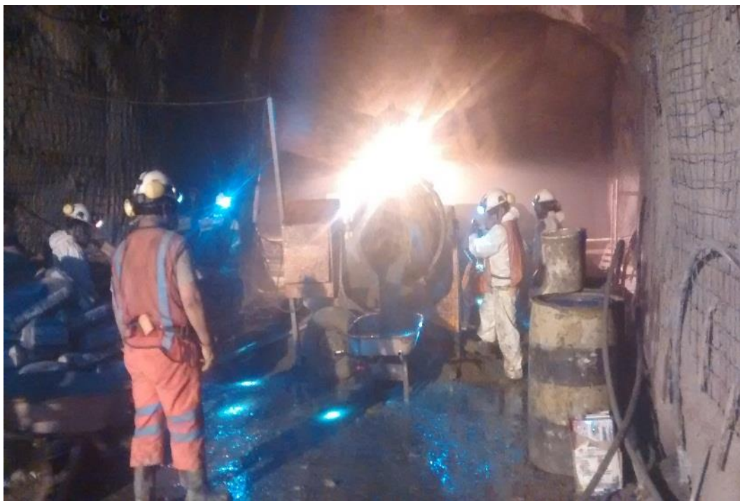
Fotografía N° 7: Encofrado y vaciado del muro n° 01 de la cámara de bomba
